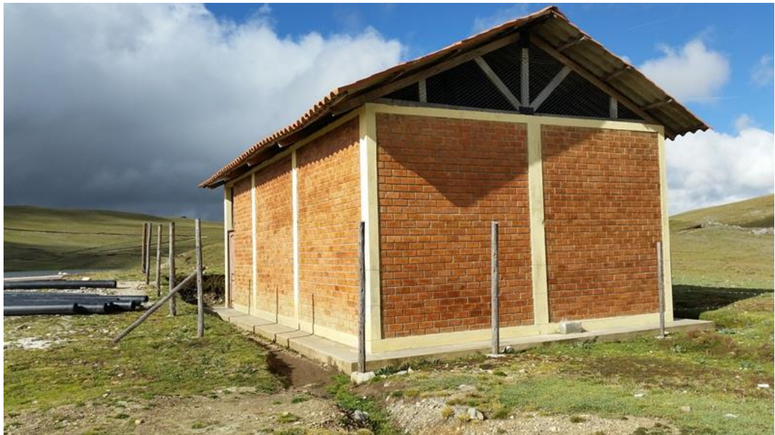
Imagen N° 20: Caseta de Reservorio.
