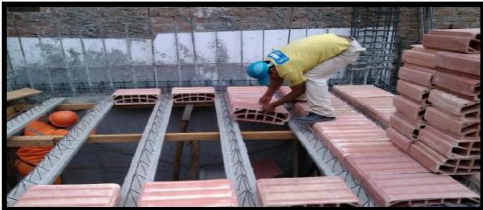
*FIGURA 4-Colocación de bovedillas y bandejas*
