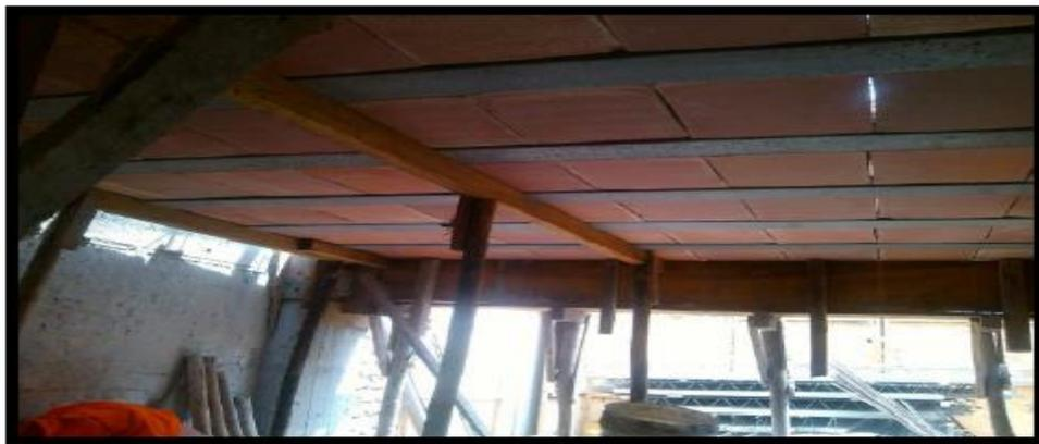
*FIGURA 2-Colocación de soleras y puntales en obra*
