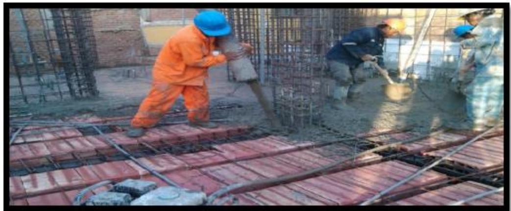
*FIGURA 7-Vaciado de concreto a la losa*
