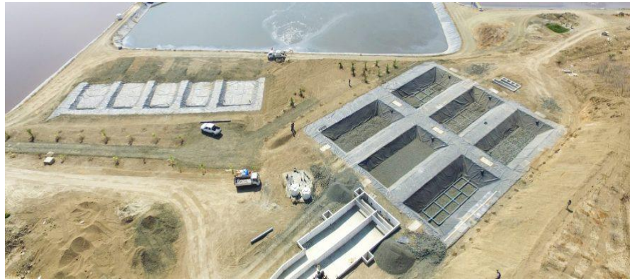
Figura 19. Empleo en Lagunas de Estabilización de Aguas Residuales
