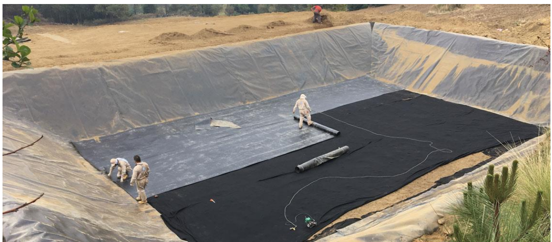
Figura 8. Geotextiles – Función de Impermeabilización
