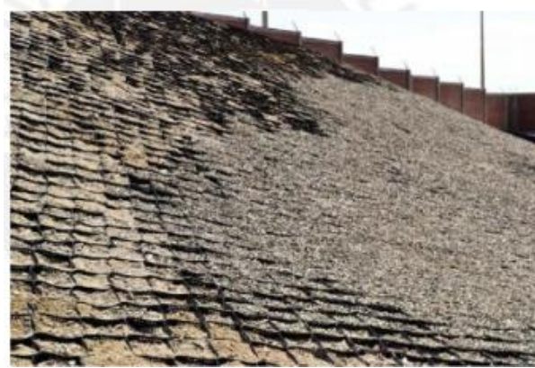
Figura 2.6: Relleno de agregados
