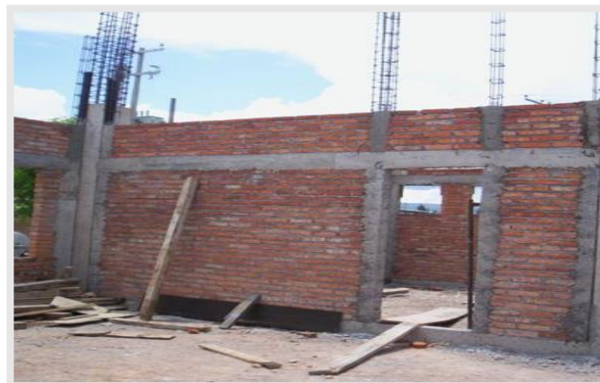
Figura 7: Conexión dentada entre muros y columna.
