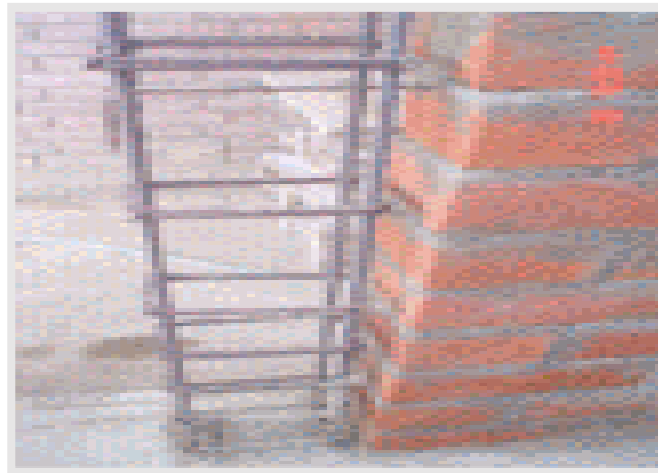
Figura 6: Conexión a ras entre muro y columna.
