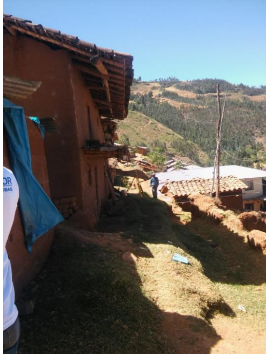
Toma fotográfica N° 03: Área de influencia del recorrido de la Red de agua potable.
