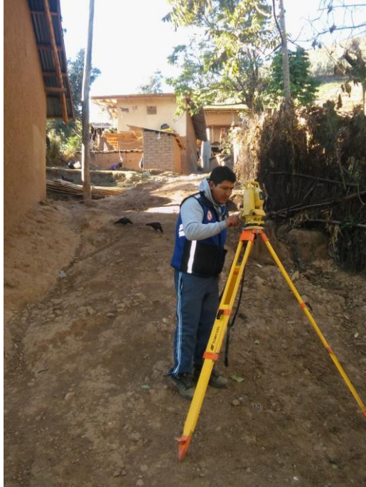
Toma fotográfica N° 01: Estacionando el equipo topográfico.
