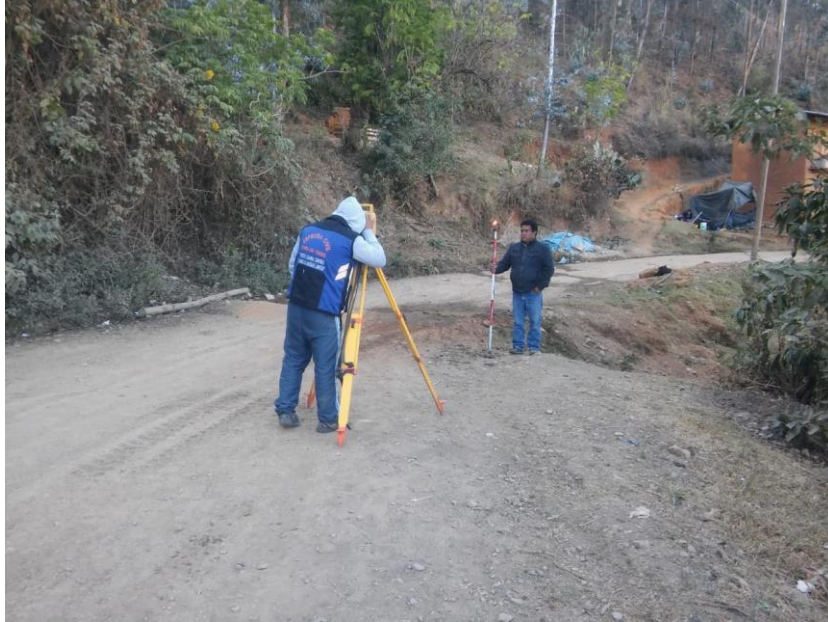
Toma fotográfica N° 05: Área del recorrido de la futura línea de distribución del Sistema de Agua Potable.
