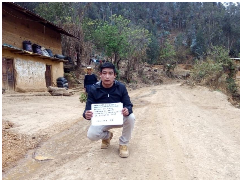
Toma fotográfica N° 06: Ubicación de calicata para la futura Red de agua potable.
