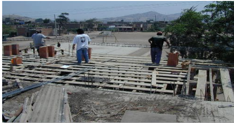
Figura 4: Encofrado del Techo
