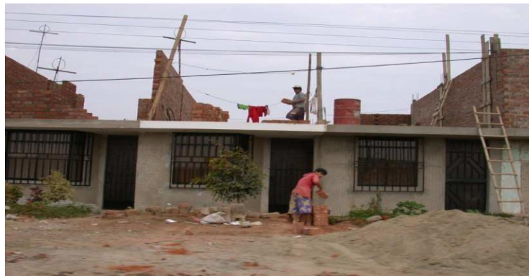
Figura 5: construcción de muros en el segundo piso
