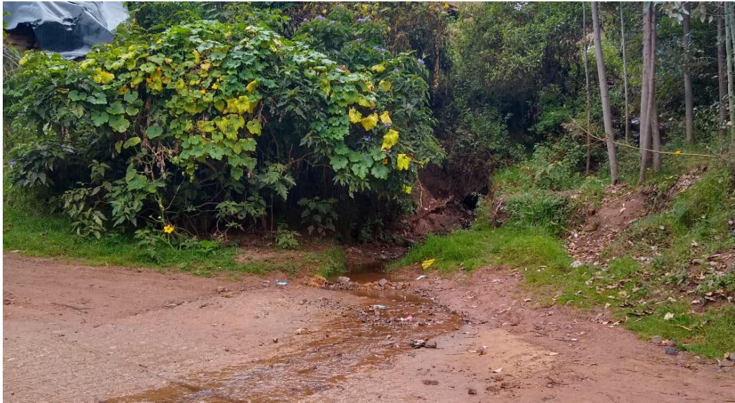
Identificación de Badén existente
