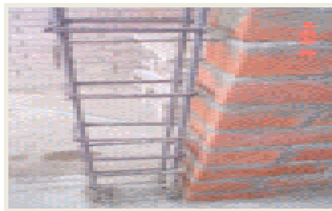
Figura 6: Conexión a ras entre muro y columna.
