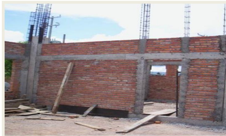
Figura 7: Conexión dentada entre muros y columna.
