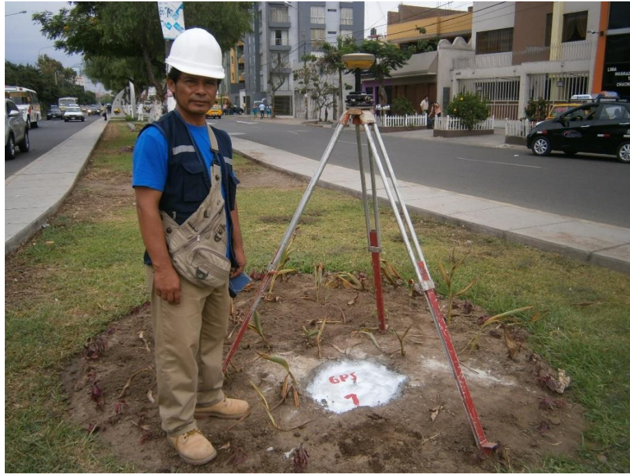
COLOCACION DE PUNTO GEODESICO EN CUADRA 39 AV. AMERICA SUR
