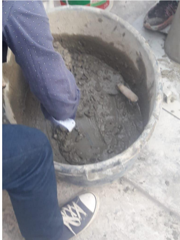
Anexo D13. Preparación de concreto.
