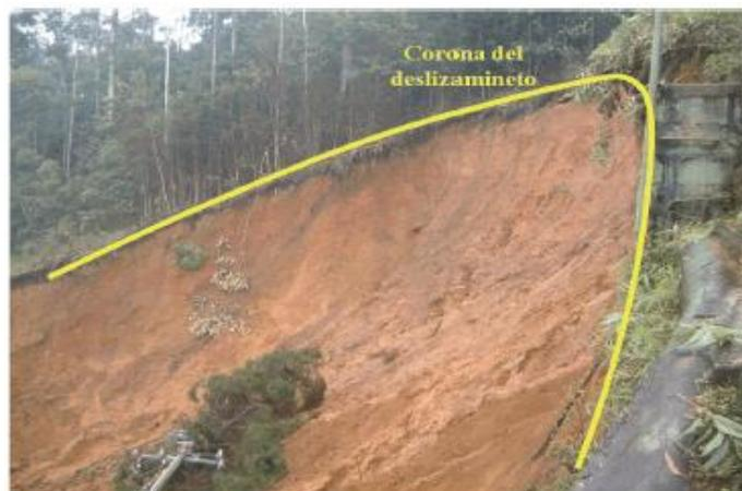
FIG. 4: Ejemplo de falla por deslizamiento.
