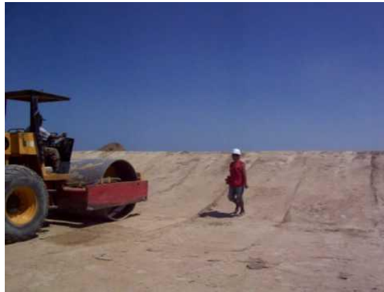
Figura 16. Compactado de fondo de laguna.
