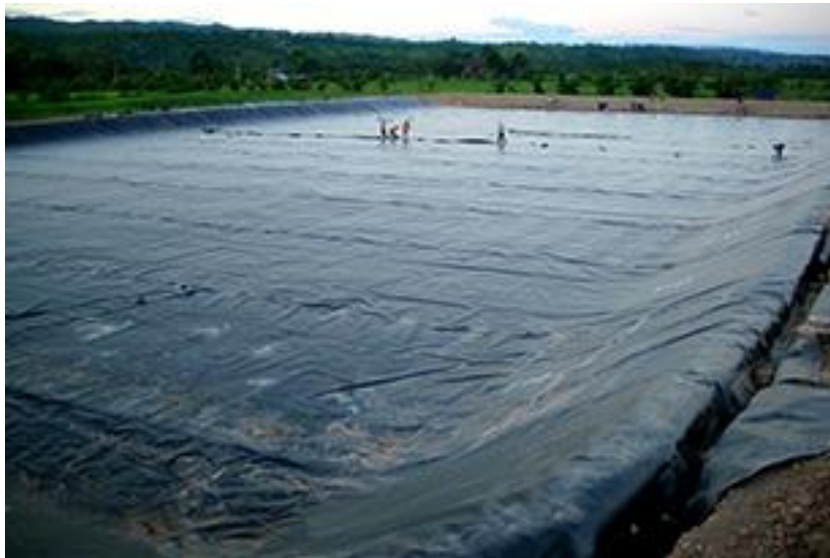
Figura 18. Revestimiento de una laguna de estabilización con polietileno
