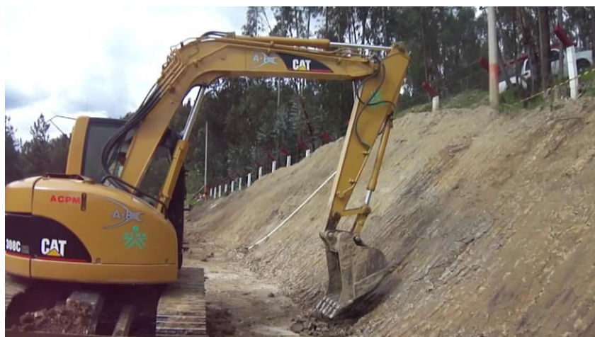
Figura 15. Perfilado y compactado de los taludes
