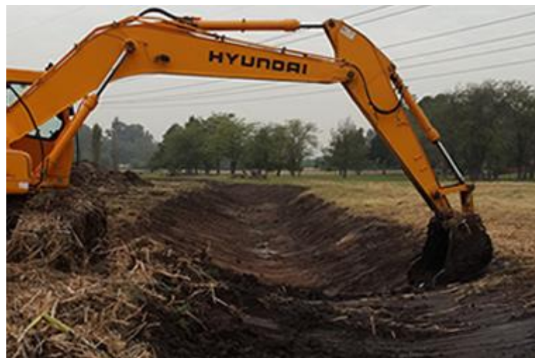
Figura 14. Excavación de las lagunas primaria
