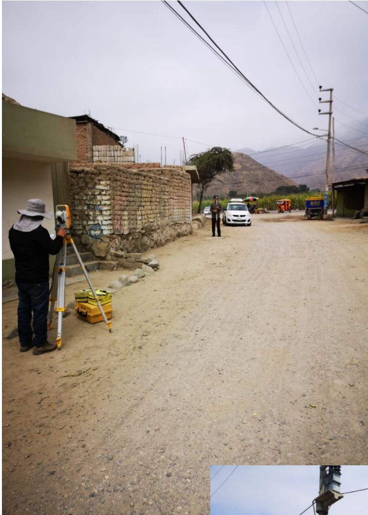
Foto 01: Toma de Punto BM para la iniciación de la topografía.
