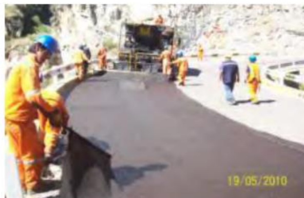
Figura 18. Aplicación de Lechada
