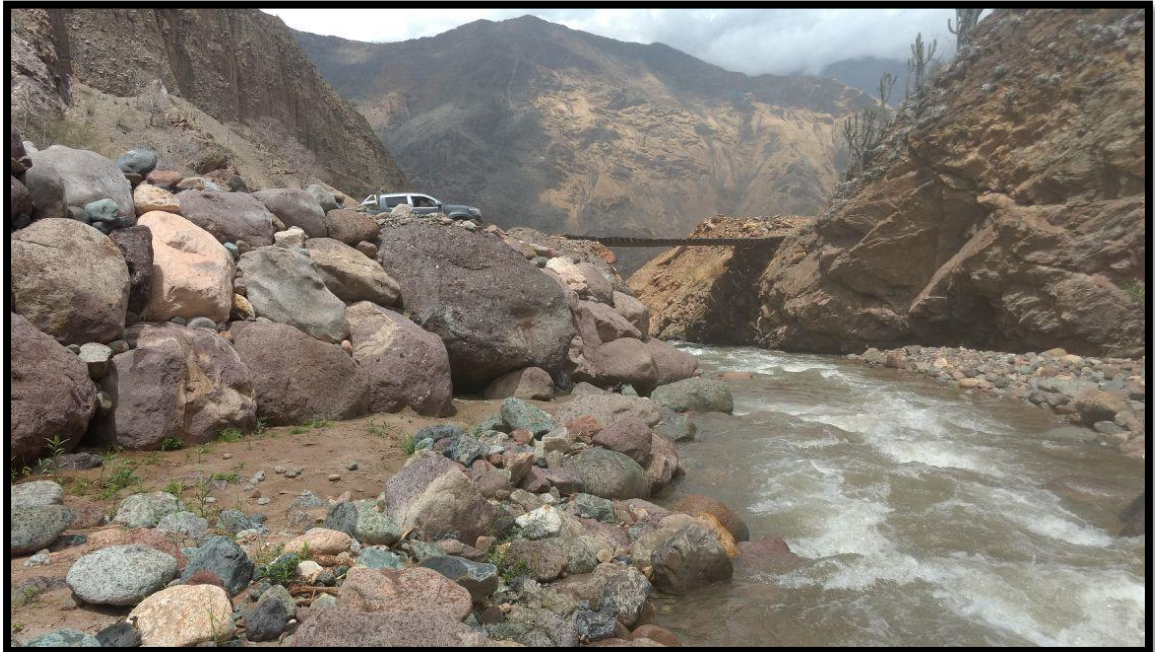
Imagen N° 5: Puente Sinchivin, está hecho a base de madera, no cuenta con barandas que cubran toda la longitud del puente.
