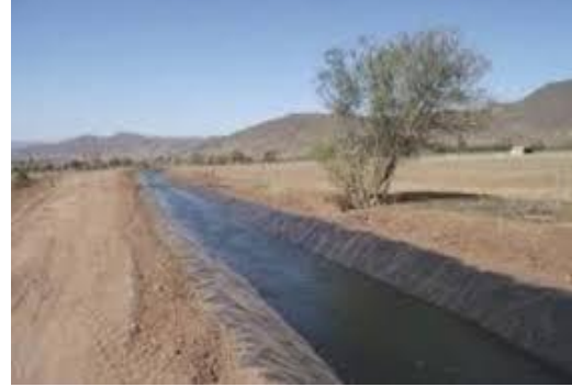
Canal artificial sin revestimiento
