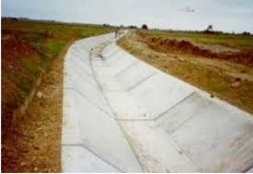
Canal artificial revestido
