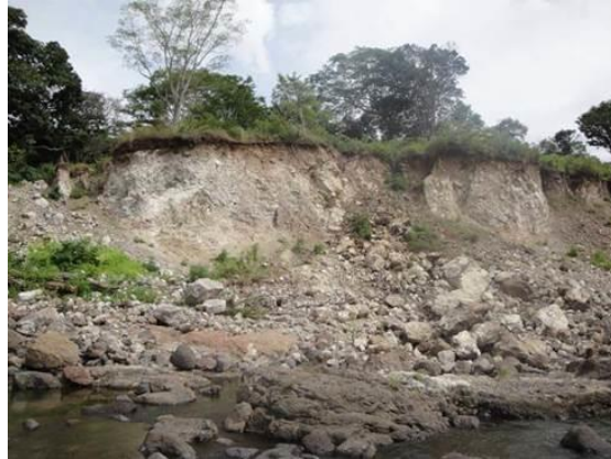
FIG. 3: Ejemplo de caída de rocas en talud.
