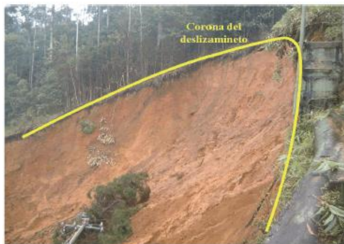
FIG. 4: Ejemplo de falla por deslizamiento.
