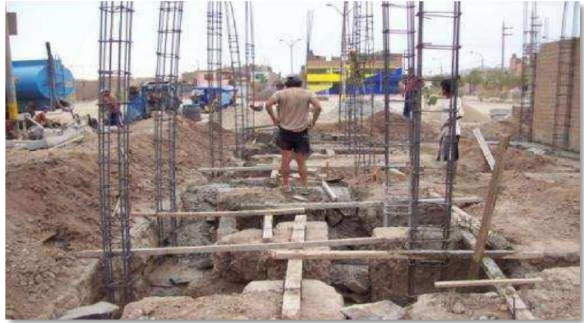
Figura 2: cimentación y armado de columnas
