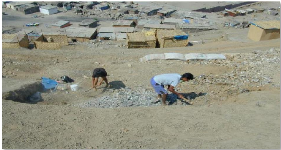
Figura 1: Nivelación del Lote
