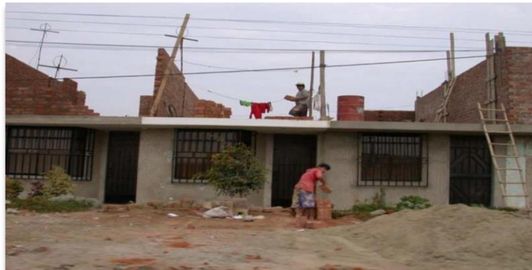
Figura 5: construcción de muros en el segundo piso
