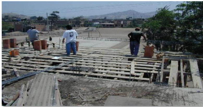
Figura 4: Encofrado del Techo
