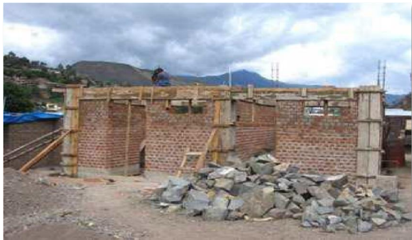
Figura 3: construcción de muros y llenado de columnas
