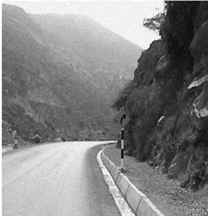
Figura 01. Visibilidad de adelantamiento Fuente: Diseño Geométrico, Romero Rodríguez
