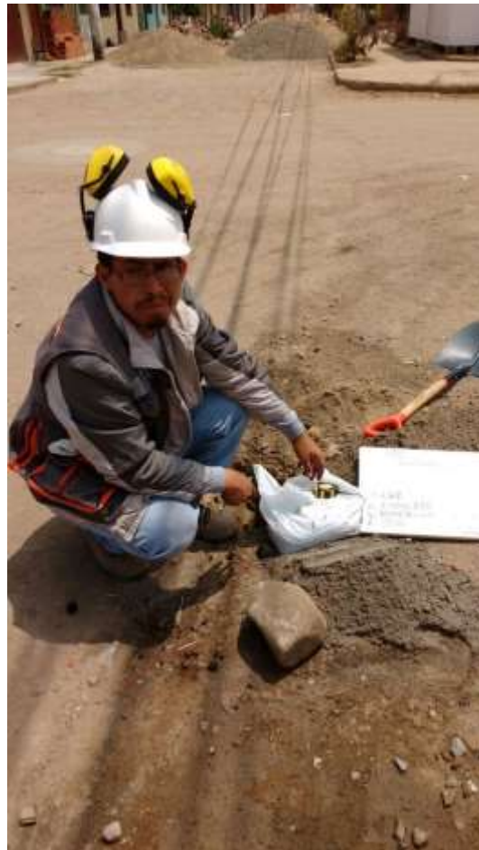
Calicata N° 02: Excavación y extracción de muestras de suelo para ser analizadas en laboratorio.
