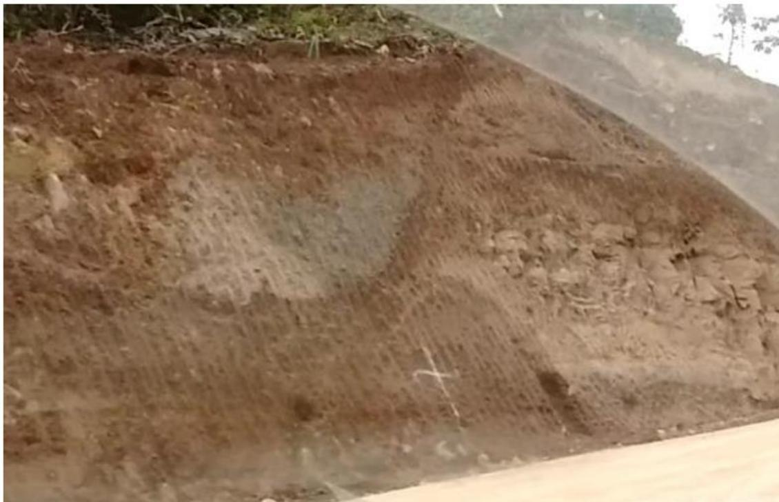
**Fotografía 15.** Km 7+400 (LI), Se observa contacto litológico de lodolitas de la formación Yahuarango que infrayacen intercalación de areniscas y lutitas de la formación Chambira.
