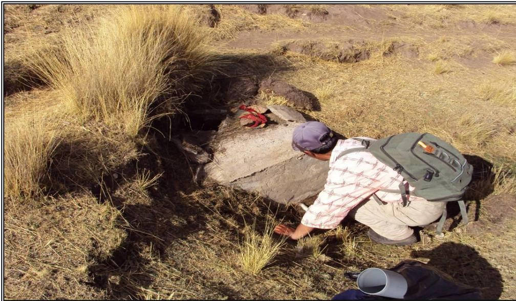
**Foto N°2.-** Captación existente, Occocata, se encuentra semienterrado, construcción rústica, en mal estado, con fisuras, no presenta accesorios como válvula de salida, canastilla, cono de rebose, no opera eficientemente, tiene 17 años de antigüedad, y no tiene cerco perimétrico.
