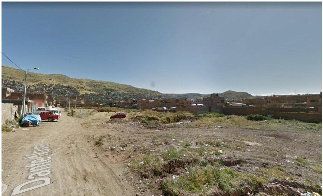
Foto numero 10: residuos de construcción utilizado como relleno.
