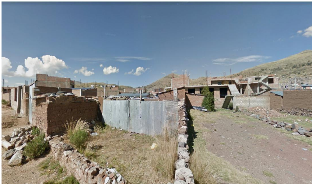
Foto numero 8: viviendas construidas en material de relleno de construccion.
