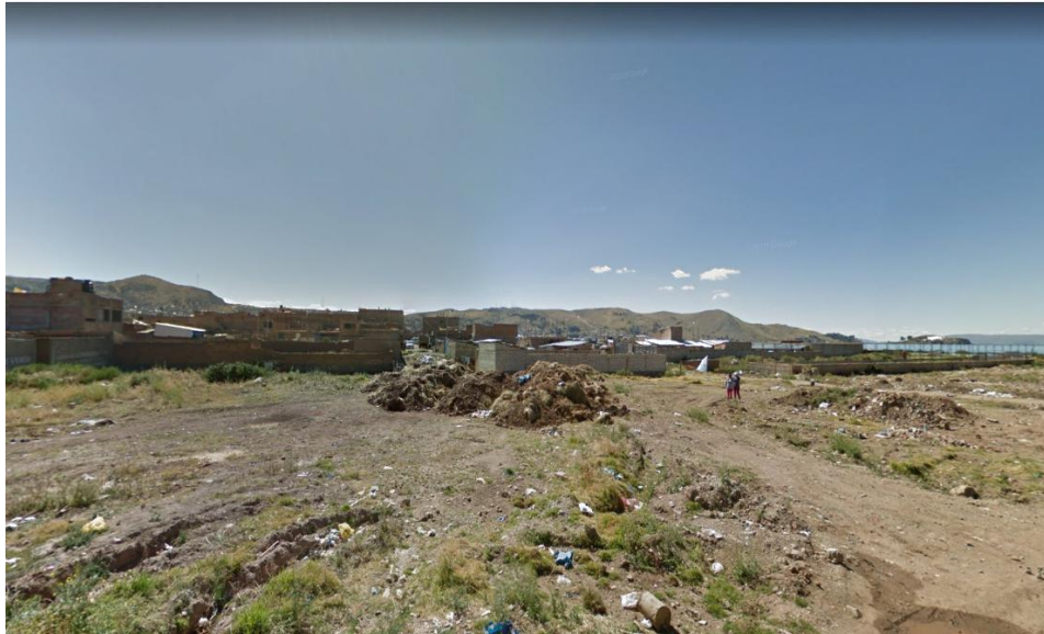
Foto numero 9: residuos de construcción utilizado como relleno.
