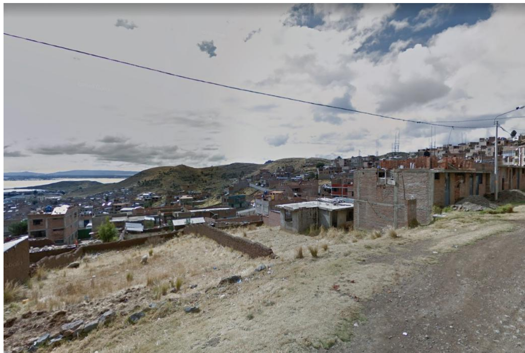
Foto numero 12: viviendas construidas sin muros de contención.
