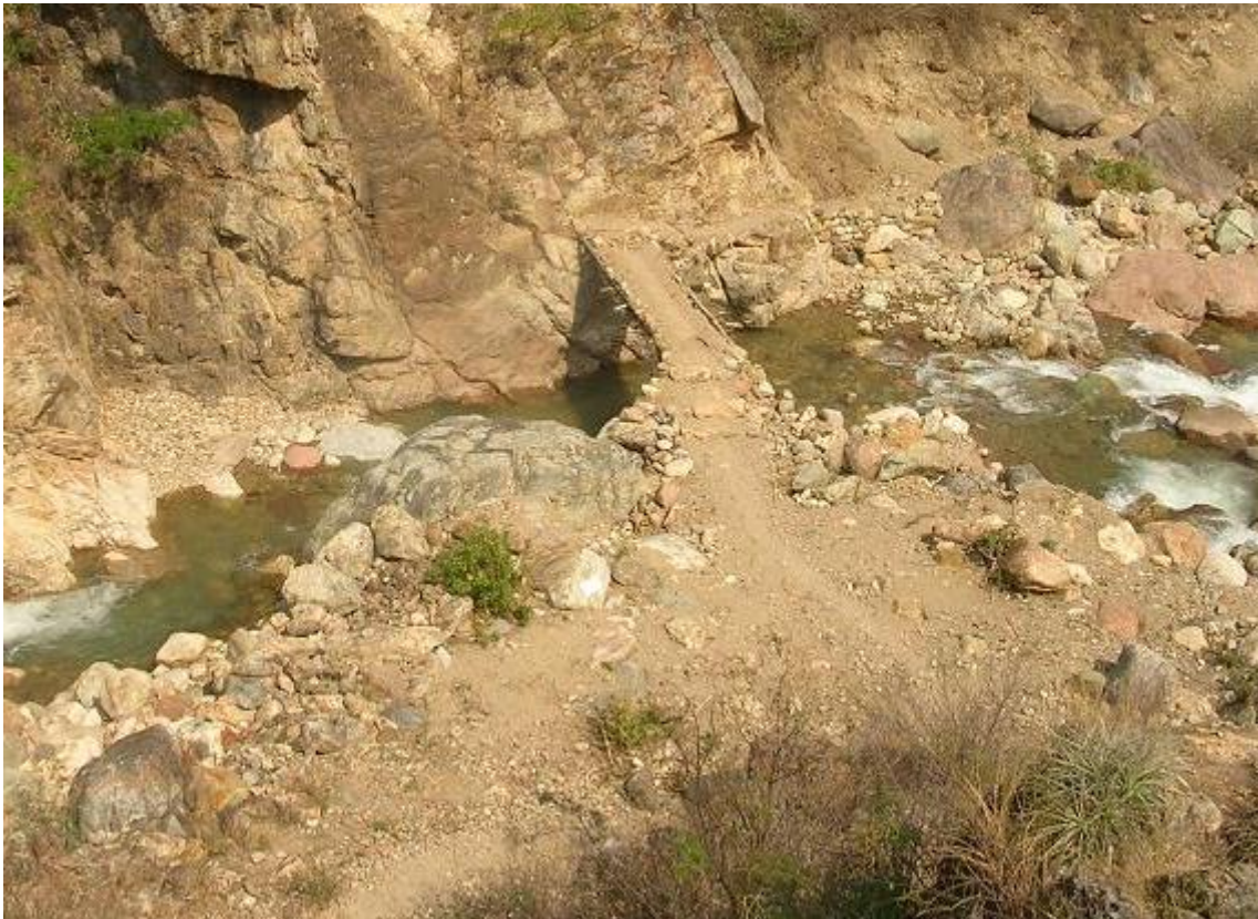
Fotografía N° 4.1.: Vista panorámica del lugar de ubicación del puente existente, margen izquierda y derecha.
