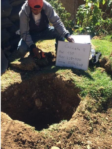
Imagen N°1 y N° 2: Realización del pozo de exploración y muestreo de Material para su estudio.
