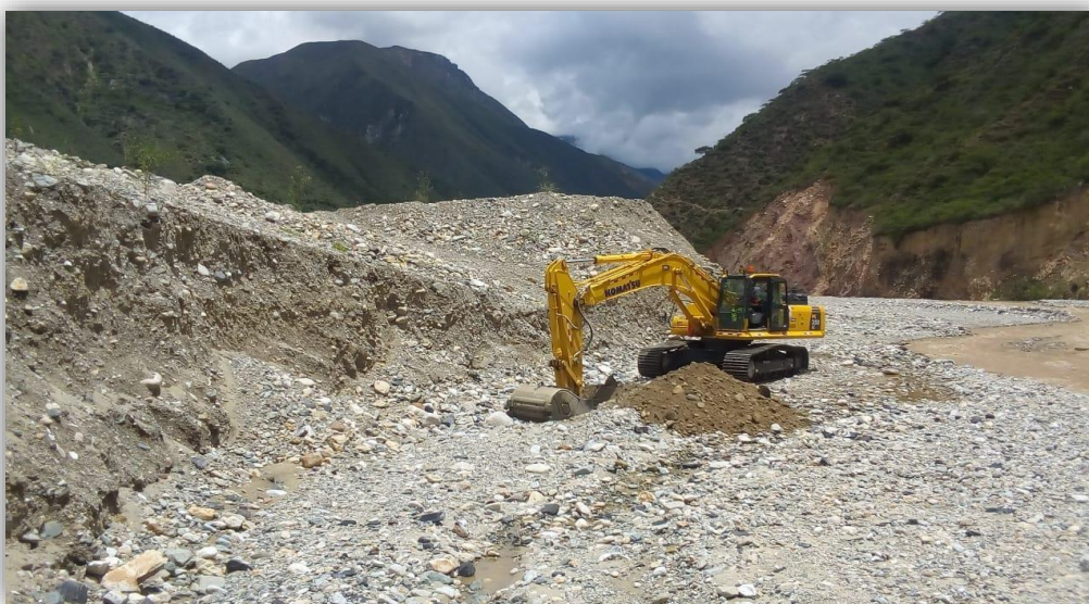
Figura 19: calicata estribo derecho
