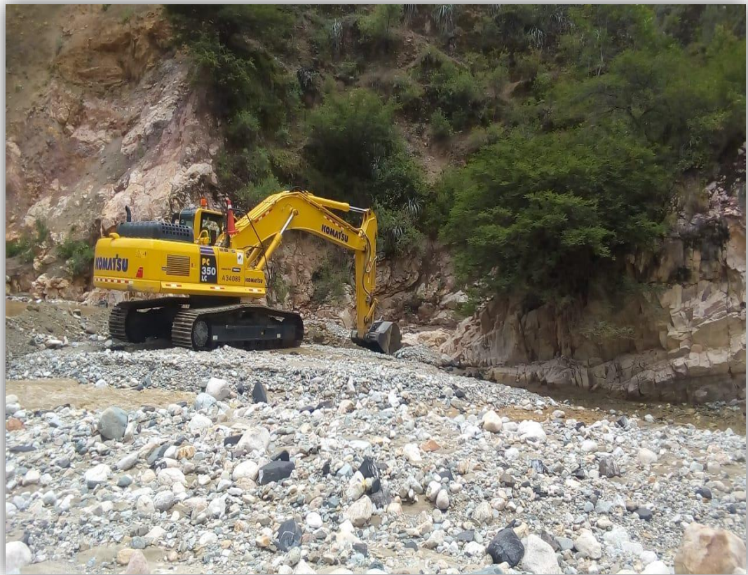
Figura 20: calicata estribo izquierdo
