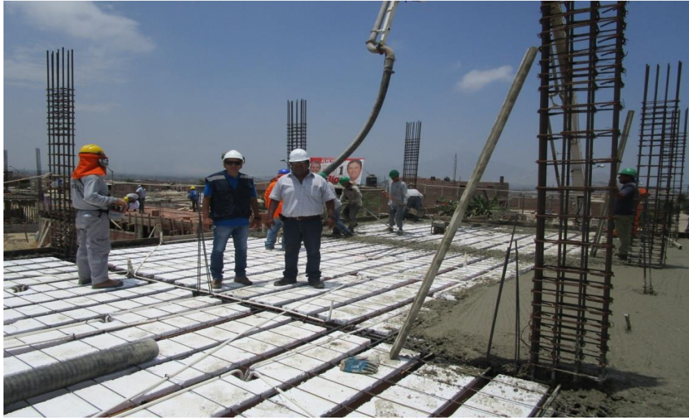
VERIFICACION DE SUPERVISION Y RESIDENCIA DE OBRA EN EL VACEADO DE LOSA ALIGERADA
