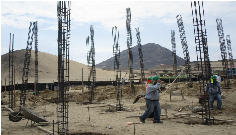
COLOCACION DE ACERO EN COLUMNAS PRINCIPALES
