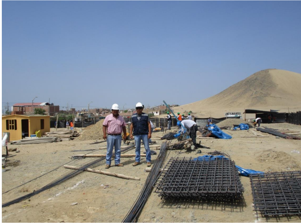
VERIFICACION DE ACERO EN ZAPATAS
