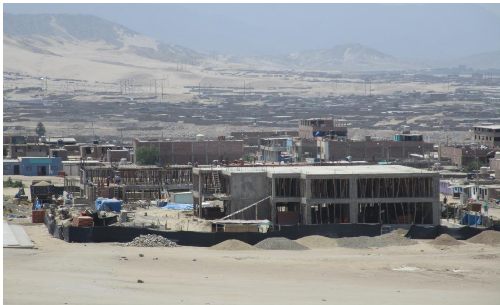
VISTA PANORAMICA DE LA OBRA
