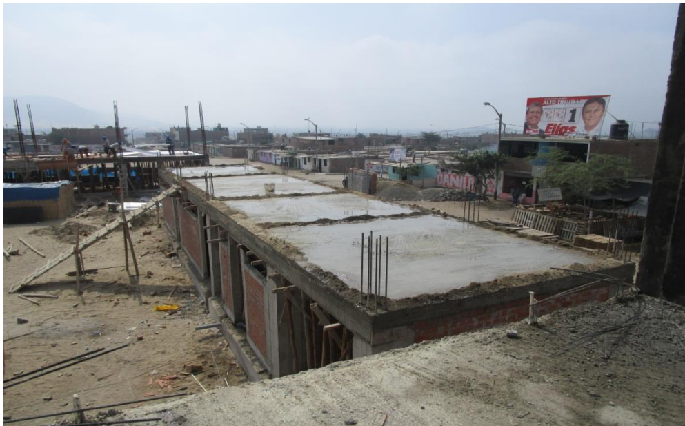
VISTA DE LA LOSA ALIGERADA DEL PABELLON B 1ER NIVEL
