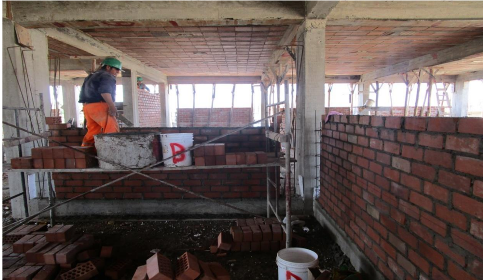
ASENTADO DE LADRILLO EN INTERIORES DEL 1ER NIVEL PABELLON C
