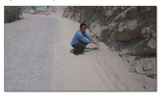
Figura 45: Desgaste de la superficie de la carretera Lucma - 09 de Octubre.
