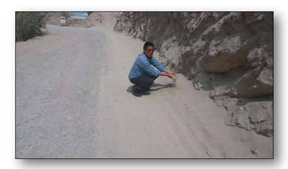
Figura 24: Ahuellamientos en el tramo Km 15+000 – Km 18+000.
