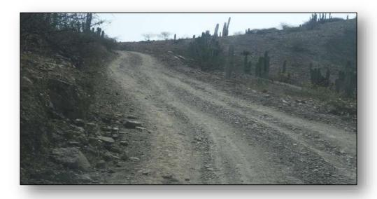
Figura 20: Desgaste de la superficie de afirmado en el tramo Km 9+000 – Km 12+000
