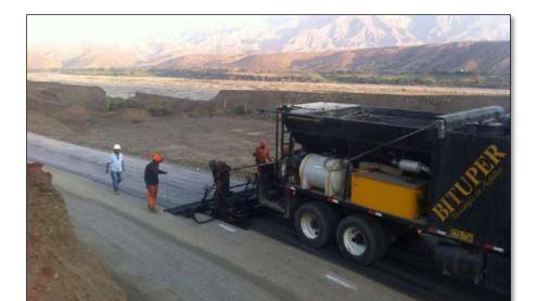
Figura 52: Colocación de Mortero Asfáltico CQS-1HP con camión Micropavimentador
