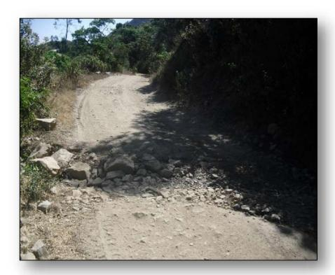
Figura 18: Presencia de polvo acumulado en el tramo Km 6+000 – Km 9+000
