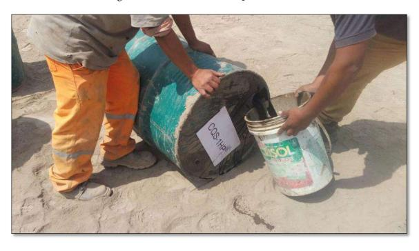
Figura 50: Emulsión asfáltica CQS-1HP
