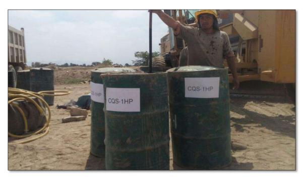
Figura 49: Emulsión asfáltica CQS-1HP
