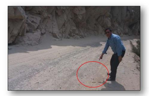
Figura 14: Desgaste de superficie de afirmado en el tramo Km 0+000 – Km 3+000.
