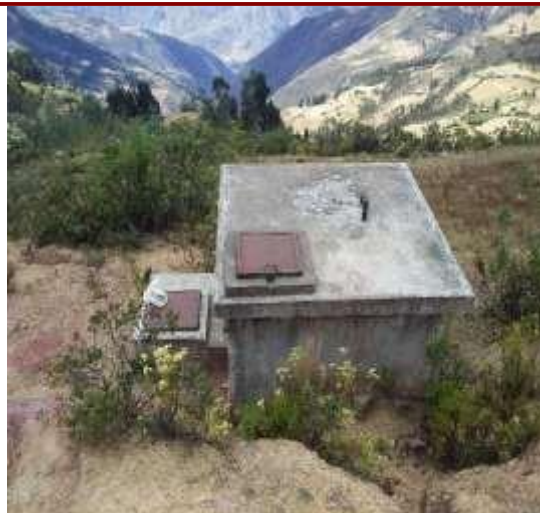
FIG. N°04: Reservorios rectangulares existentes con deterioro en sus estructuras, presentando agrietamiento y erosión del concreto, sin ningún tipo de mantenimiento, no presentan un sistema de cloración y cerco perimétrico.
