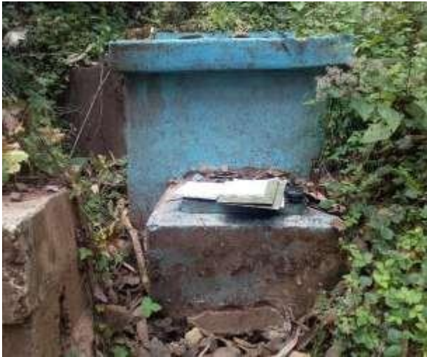
FIG. N°01. 02: captaciones típicas con deterioro en sus estructuras, presentado agrietamientos y erosión del concreto, originando que el caudal se pierda por fricción del agua.
