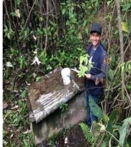
FIG. N°01. 02: captaciones típicas con deterioro en sus estructuras, presentado agrietamientos y erosión del concreto, originando que el caudal se pierda por fricción del agua.
