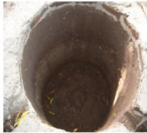
Agujero para el Biodigestor
