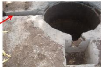
Agujero para entrada de Aguas Residuales
