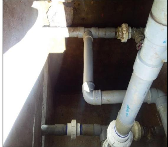
**FIG. N°05 - 06:** Reservorios circulares existentes con deterioro en sus estructuras, presentando agrietamiento y erosión del concreto, sin ningún tipo de mantenimiento, no presentan un sistema de cloración y cerco perimétrico, las tuberías en su interior en mal estado los interiores sin un cuidado adecuado y no presenta un sistema de cloración adecuado.
