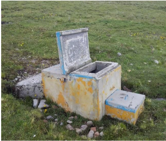
FIG. N°01. 02: captaciones típicas con deterioro en sus estructuras, presentado agrietamientos, los orificios en mal estado, y filtraciones de agua por las paredes.
