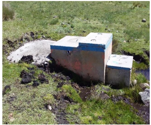
FIG. N°01. 02: captaciones típicas con deterioro en sus estructuras, presentado agrietamientos, los orificios en mal estado, y filtraciones de agua por las paredes.
