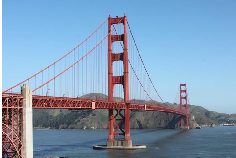
Ilustración 5: Puente Golden Gate (1280.2 m) –E.E.U.U.
