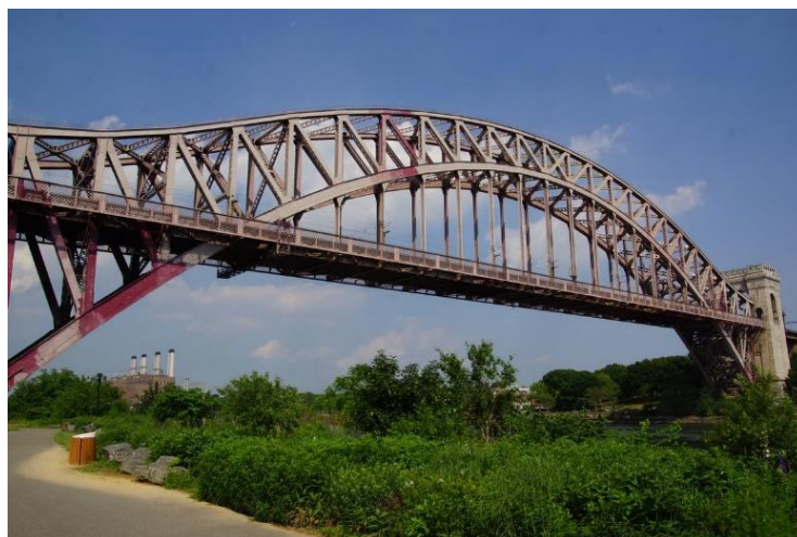
Ilustración 6: Puente de la Puerta del Infierno (5200 m) –E.E.U.U.
