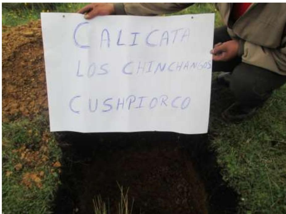
**FIGURA N°5-6:** Calicatas: Excavación de calicatas para los ensayos correspondientes para la ejecución del proyecto del caserío Cushpiorco.
