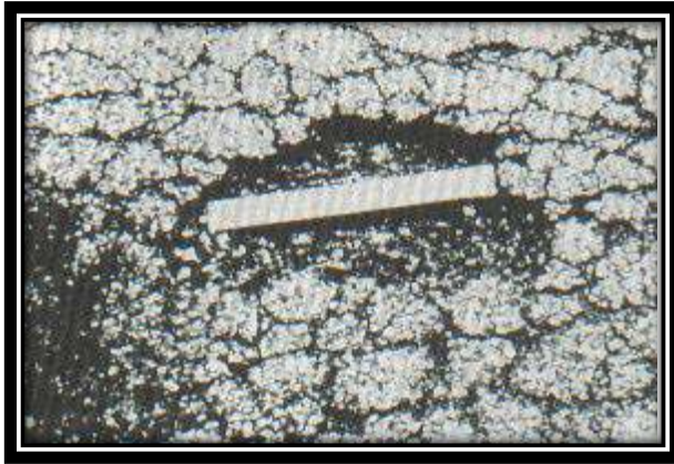
Figura A13-a. Hueco de baja severidad.
