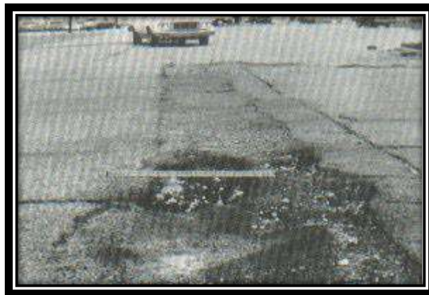
Figura A11-b. Parcheo y acometidas de servicios públicos de severidad media.
