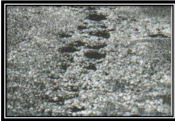
Figura A18-b. Meteorización / desprendimiento de agregados de severidad media.
