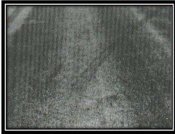
Figura A2-a. Exudación de baja severidad.
