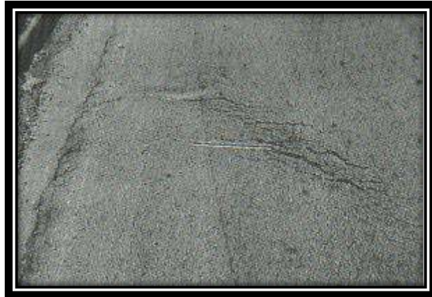
Figura A16-a. Grieta parabólica (slippage) de baja severidad.
