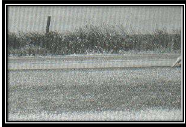
Figura A5-a. Corrugación de baja severidad.
