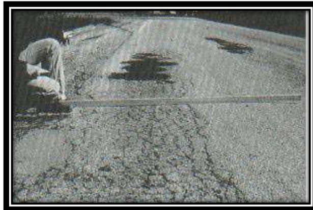
Figura A1-b. Piel de cocodrilo de severidad media.
