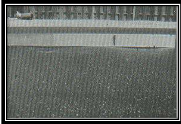
Figura A5-a. Corrugación de baja severidad.
