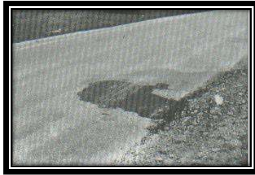
Figura A11-a. Parcheo y acometidas de servicios públicos de baja severidad.
