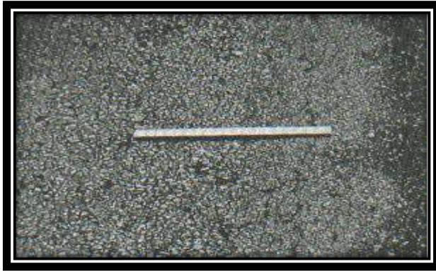
Figura A18-a. Meteorización / desprendimiento de agregados de baja severidad.
