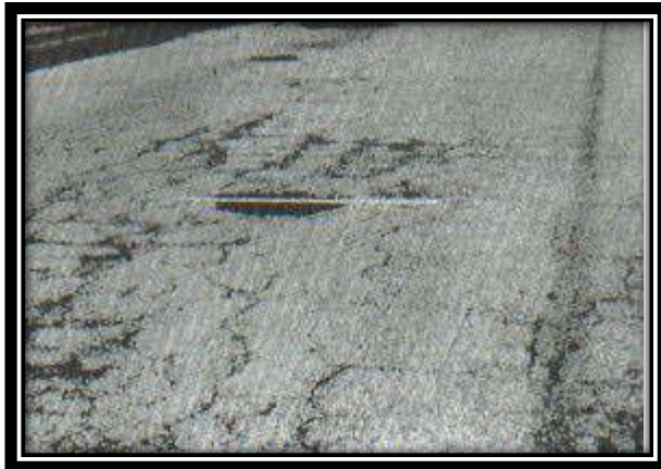
Figura A13-a. Hueco de baja severidad.
