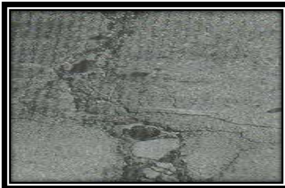
Figura A10-b. Grietas longitudinales y transversales de severidad Media
