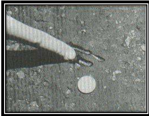
Figura A2-a. Exudación de baja severidad.
