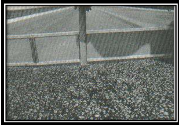
Figura A14-a. Ahuellamiento de baja severidad.
