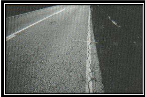
Figura A1-b. Piel de cocodrilo de severidad media.
