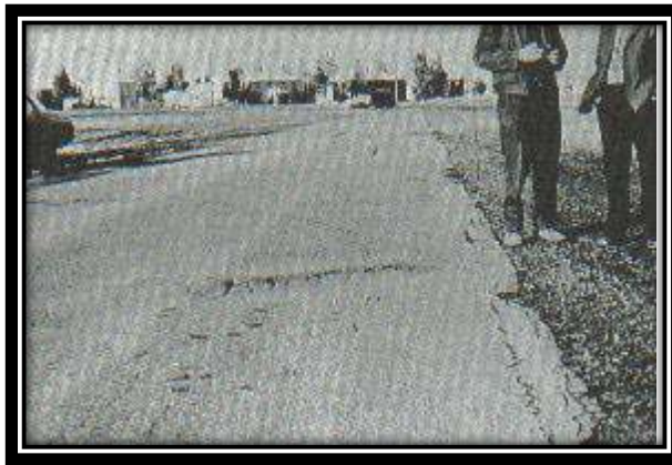
Figura A4-a. Abultamientos y hundimientos de baja severidad.
