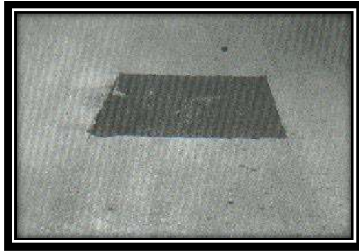
Figura A11-a. Parcheo y acometidas de servicios públicos de baja severidad.
