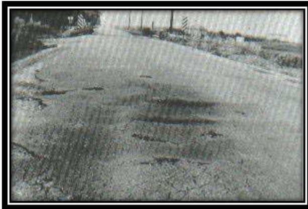
Figura A15-a. Desplazamiento de baja severidad.
