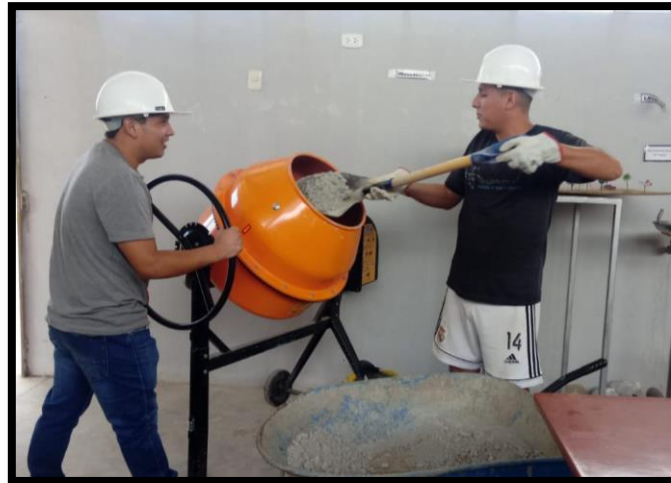
Figura 19 – Se coloca el agregado y cemento a la mezcladora
