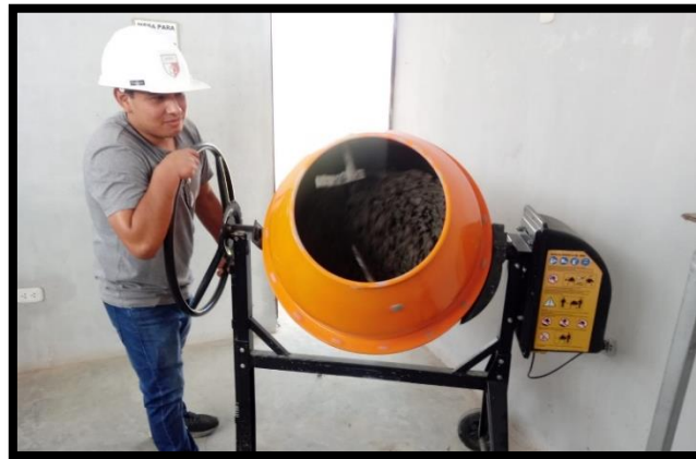
Figura 35 – Todos los agregados son mezclados uniformemente
