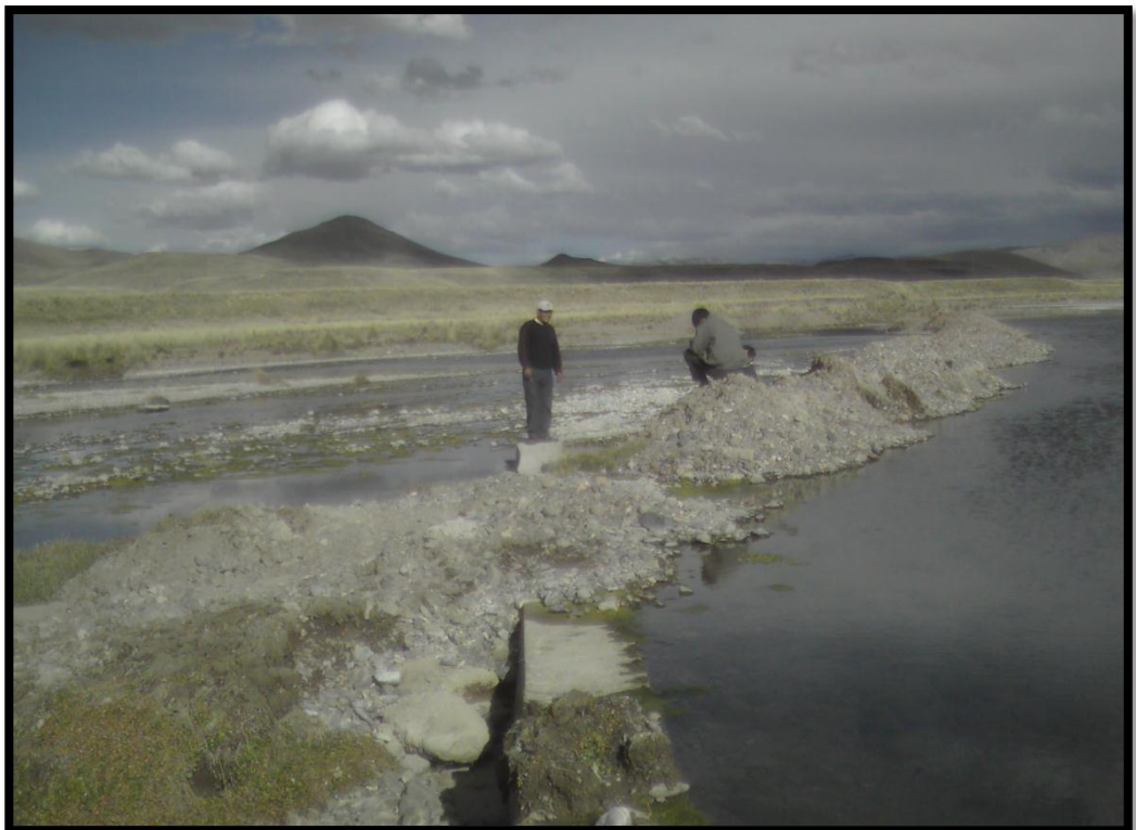
Figura N°01 Se observa en la imagen la falta de mantenimiento de la captación
