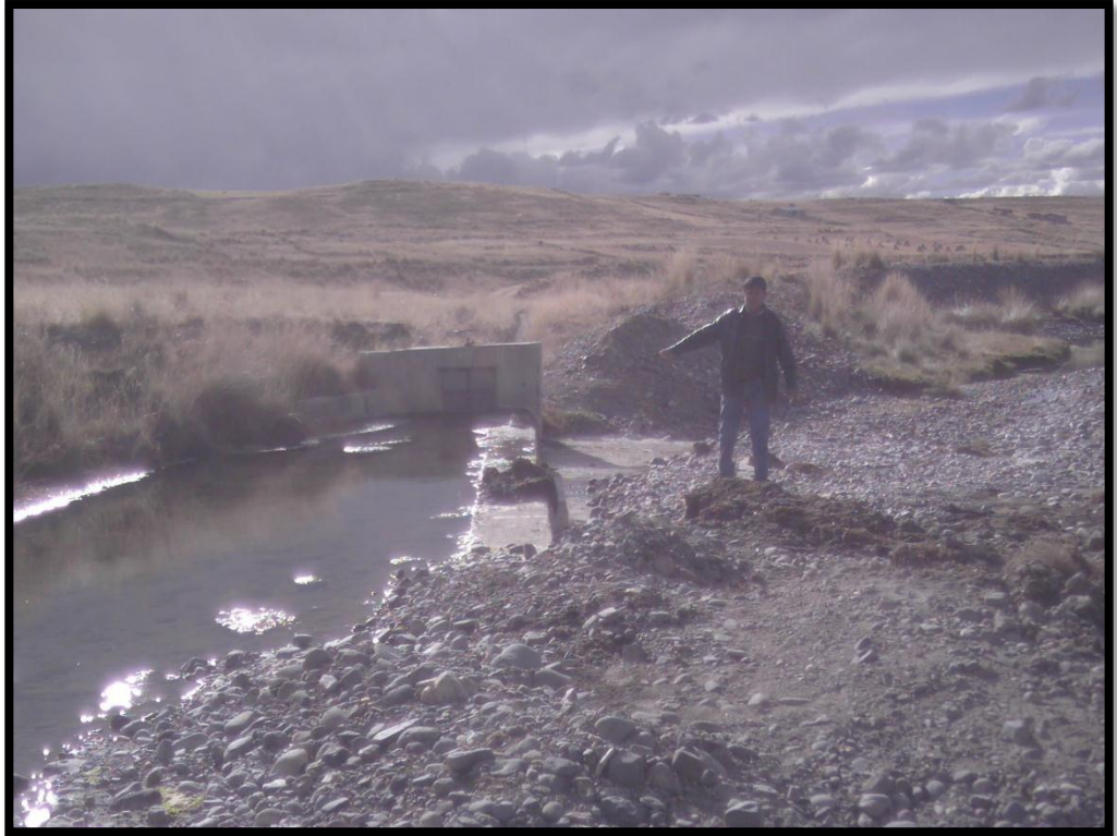
Figura N°01 Se observa en la imagen la falta de mantenimiento de la captación
