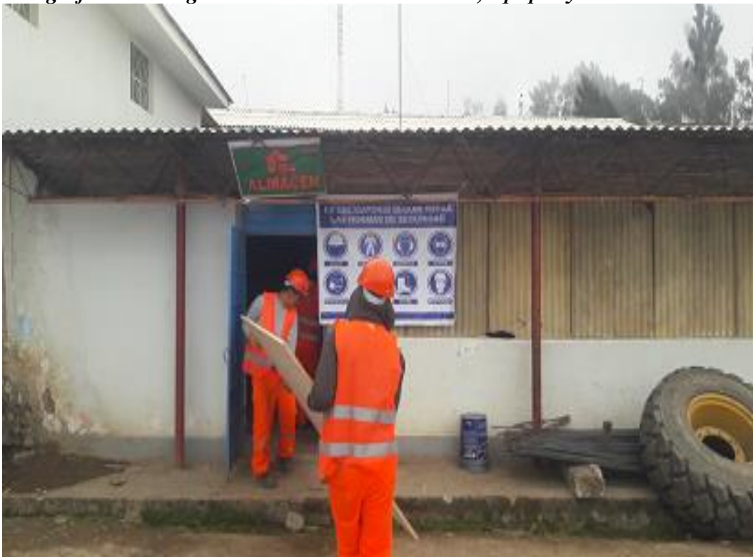
Fotografía N° 4: Ingreso al almacén de materiales, equipos y herramientas.
