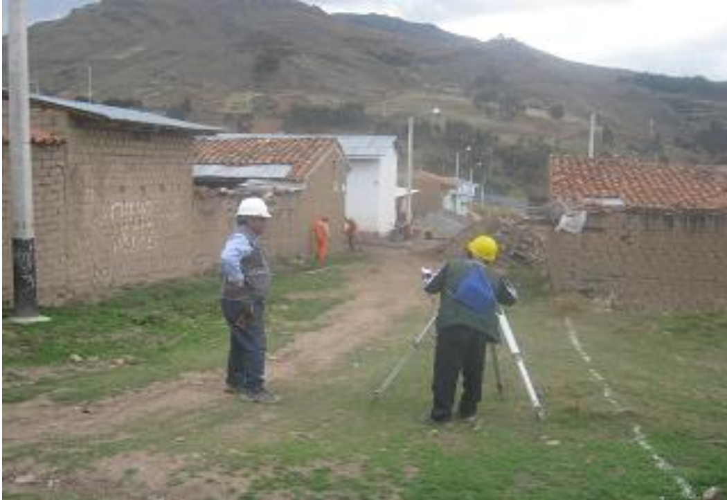
Fotografía N° 13: Trazo y replanteo.
