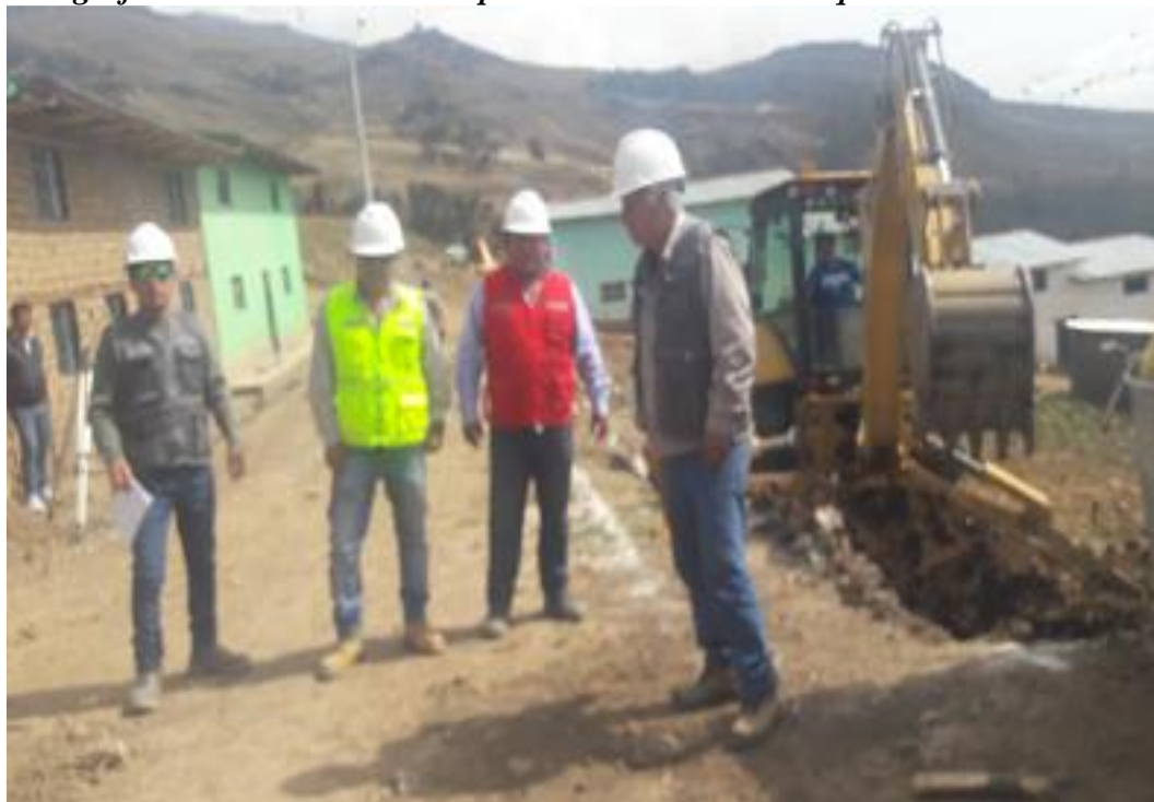
Fotografía N° 12: Coordinación para excavación con maquinaria.
