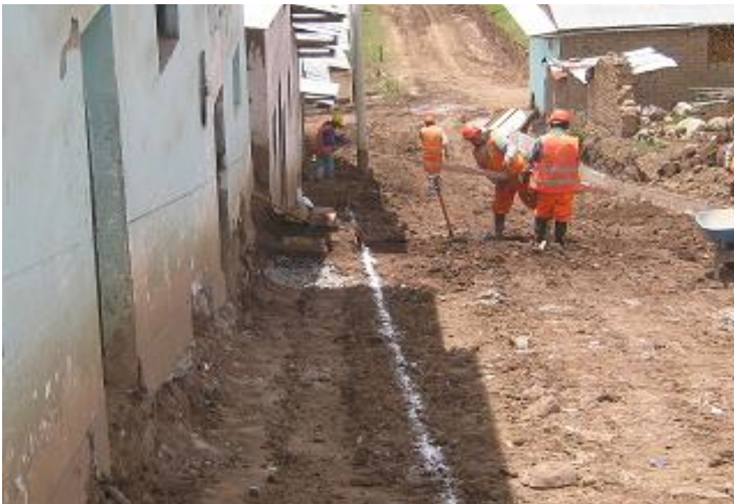
Fotografía N° 14: Trazo y replanteo.
