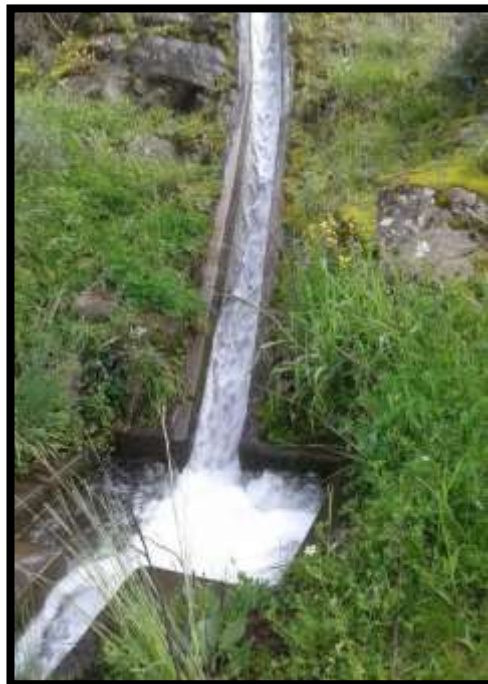
FOTO N° 4: VISTA DE RAPIDAS EXISTENTES DE CONCRETO
