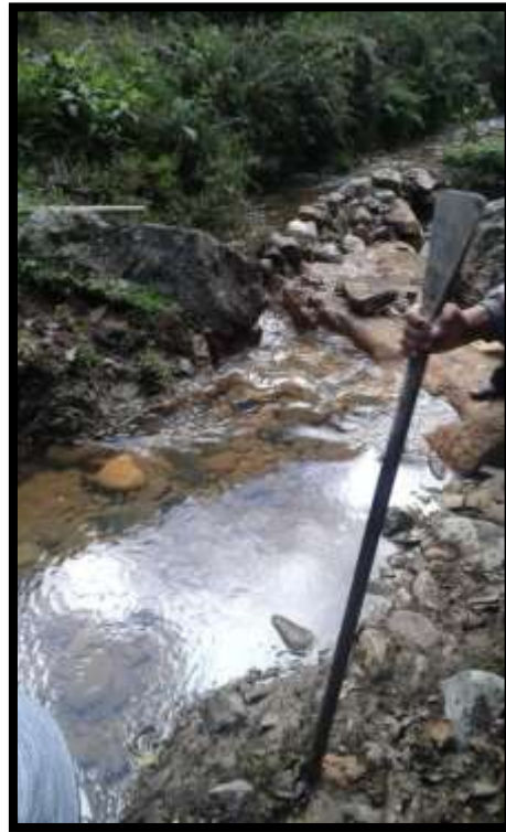
.FOTO N°3: VISTA DE LA CAPTACION DONDE SERA CAPTARA EL AGUA PARA SER CONDUCCIDO POR UN CANAL RECTANGULAR
