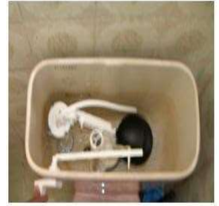
Tanque después de la descarga, con la boya inclinada, lo que permite el ingreso del agua.
