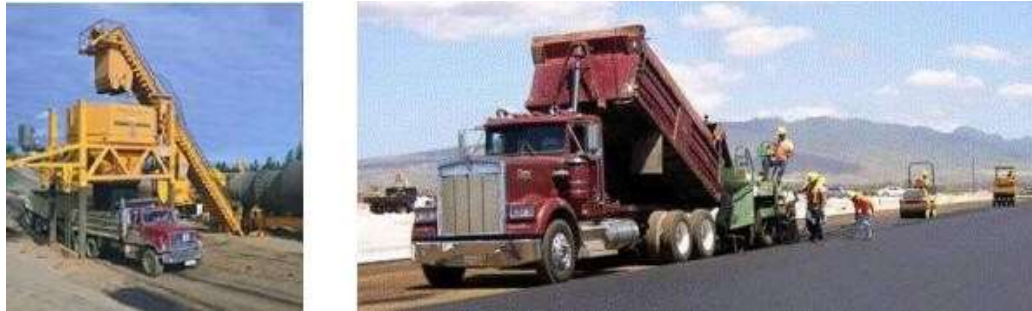
Figura 08: Sobre-carpeta de concreto de cemento portland
