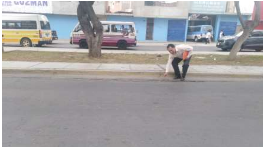
Figura 23: Depresion de severidad media
