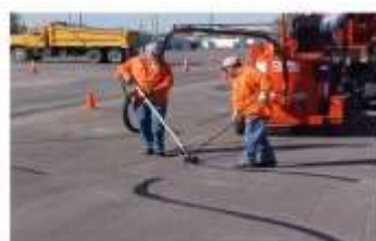
Sellado de la grieta
