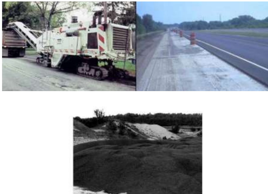
Figura 11: Maquina fresadora, pavimento fresado y material fresado
