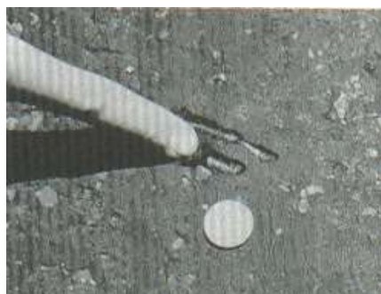
Figura 16: Exudación de severidad Media
