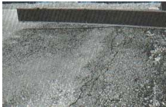
Figura 21: Abultamiento de severidad media
