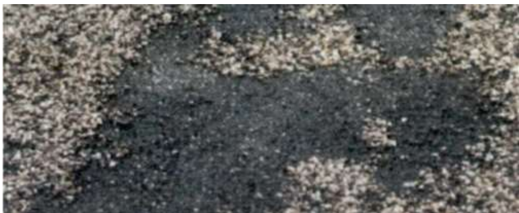
Figura 45: Gravedad 3: Continuo con aparición de la base granular
