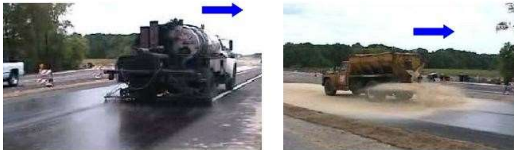
Figura 03: Sello arena sello arena – asfalto
