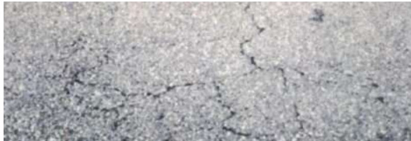
Figura 30: Gravedad 2 Malla mediana (entre 0.30 y 0.5)
