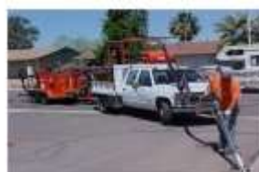
Limpieza de la grieta con aire comprimido
