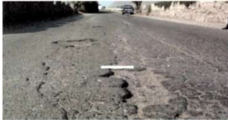
Figura 47 Gravedad 2: Diámetro entre 0.2 y 0.5 m
