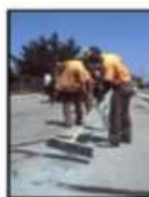
Aplicación de arena
