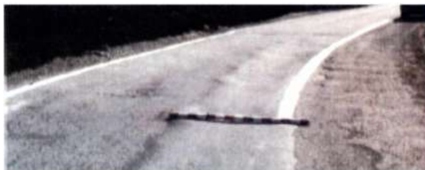
Figura 40: Gravedad 3 Profundidad > 12 mm
