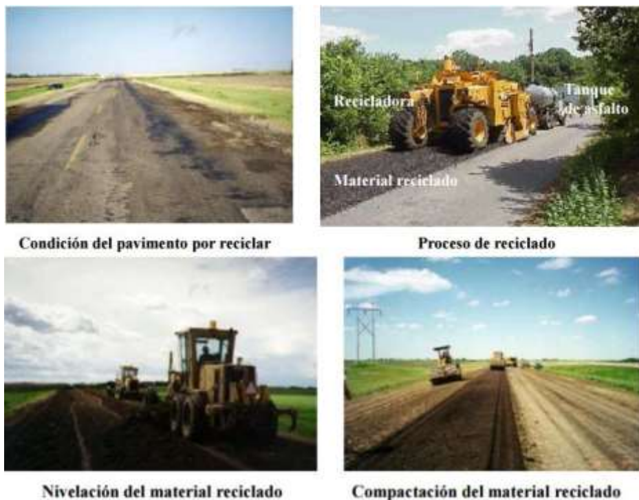
Figura 10: Reciclado en frío en sitio y con emulsión asfáltica
