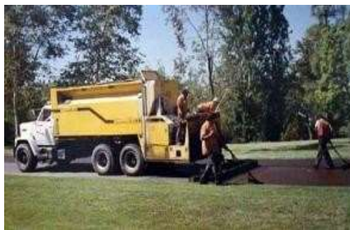
Figura 06: Aplicación de lechada asfáltica y micro-aglomerado en frío
