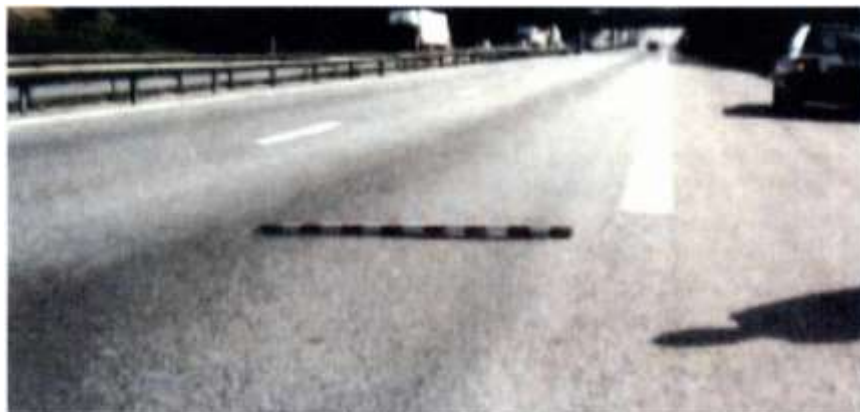
Figura 39: Gravedad 2 Profundidad > 6 mm y \leq 12 mm
