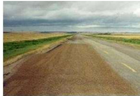
Figura 05: Procedimiento típico de arenado
