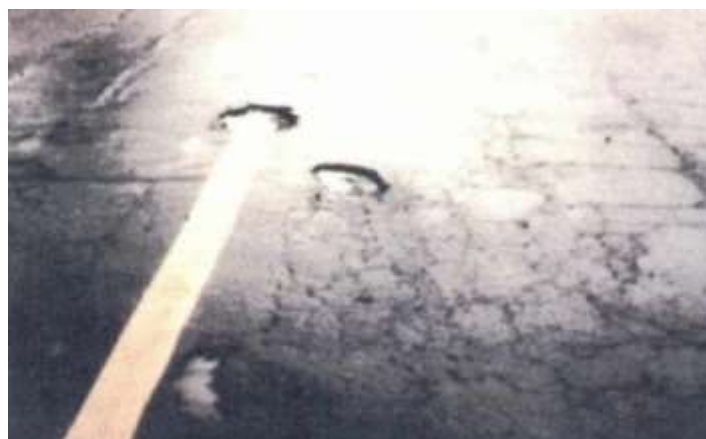
Figura 46 Gravedad 1, Diámetro < 0.2 m
