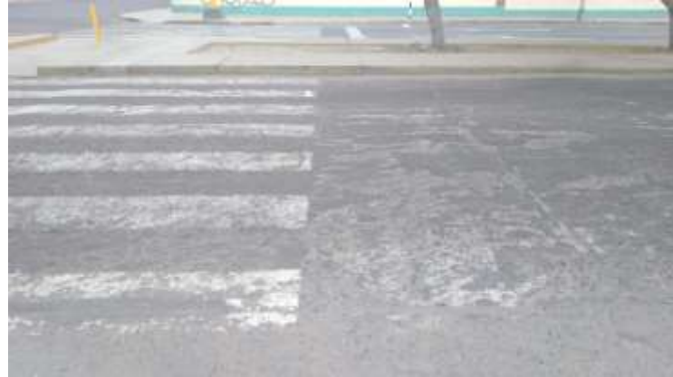
Figura 13: Piel de cocodrilo de severidad media
