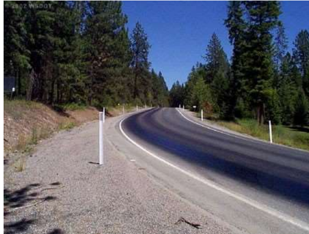
Figura 17: Exudación de severidad Alta
