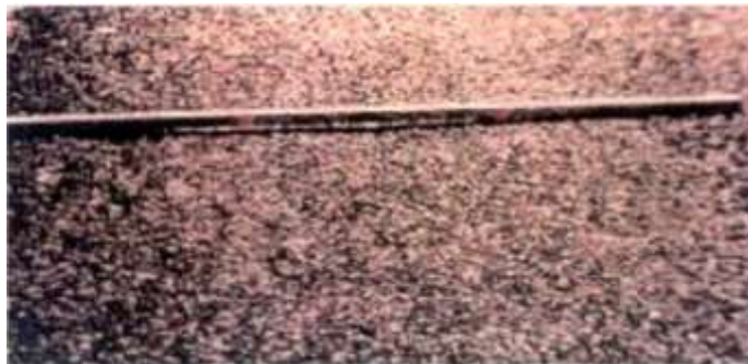
Figura 34: Gravedad 1 Profundidad sensible al usuario < 2 cm
