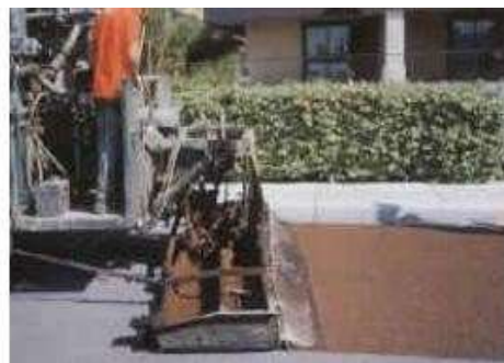
Figura 06: Aplicación de lechada asfáltica y micro-aglomerado en frío
