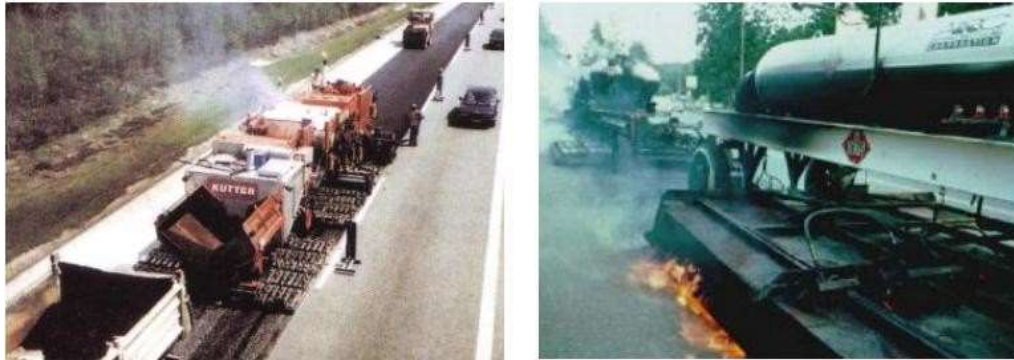
Figura 09: Reciclado superficial en sitio y en caliente
