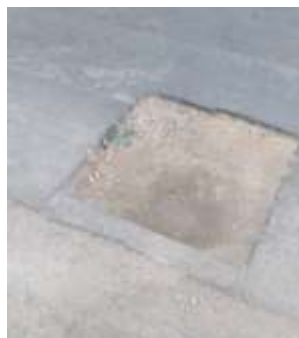
Figura 27: Parcheo de severidad alta
