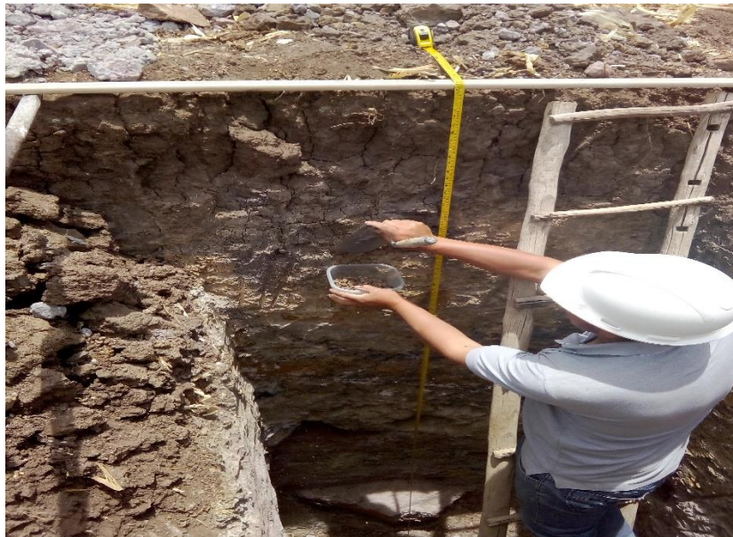
Calicata N° 05: Excavación y extracción de muestras de suelo para ser analizadas en laboratorio.
