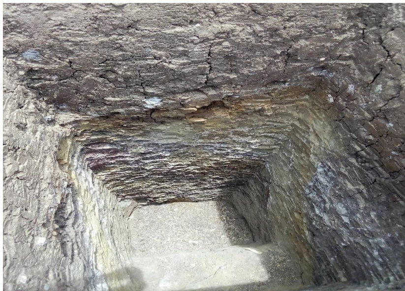
Calicata N° 04: Excavación y extracción de muestras de suelo para ser analizadas en laboratorio.
