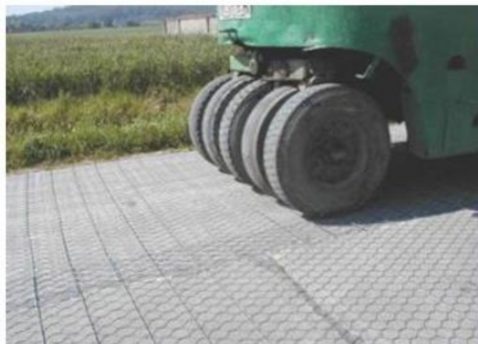
Imagen N° 12: “Aplanado de la Malla Metálica”
