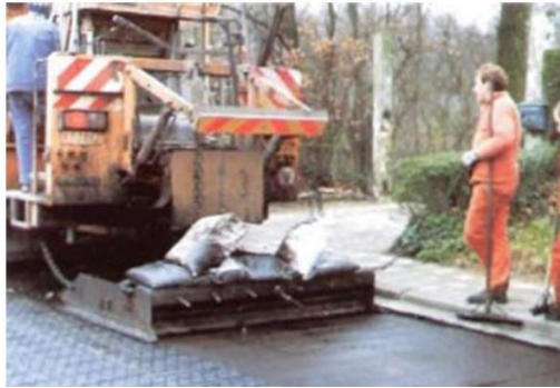
Imagen N° 18: “Esquipo para colocación de slurry”
