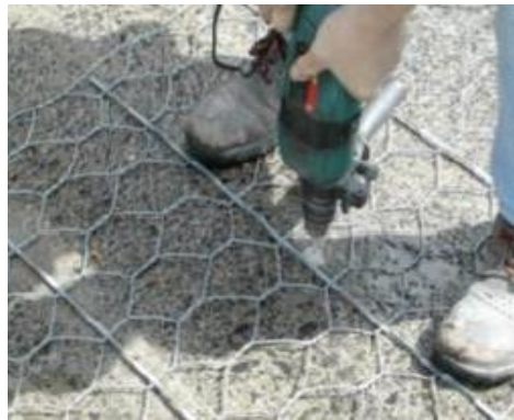
Imagen N° 13: “Fijación de malla usando la platina torsionada” Fuente: Prodac – Perú
