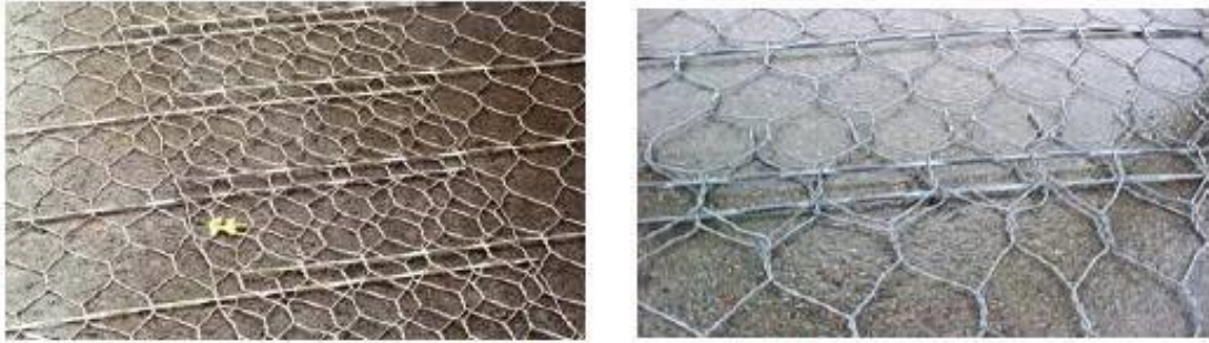
Imagen N° 11: “Traslape Longitudinal y Transversal”
