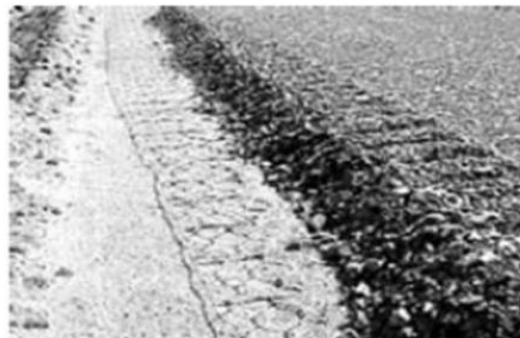
Imagen N°19: “Colocación de la carpeta de Concreto Asfáltico”
