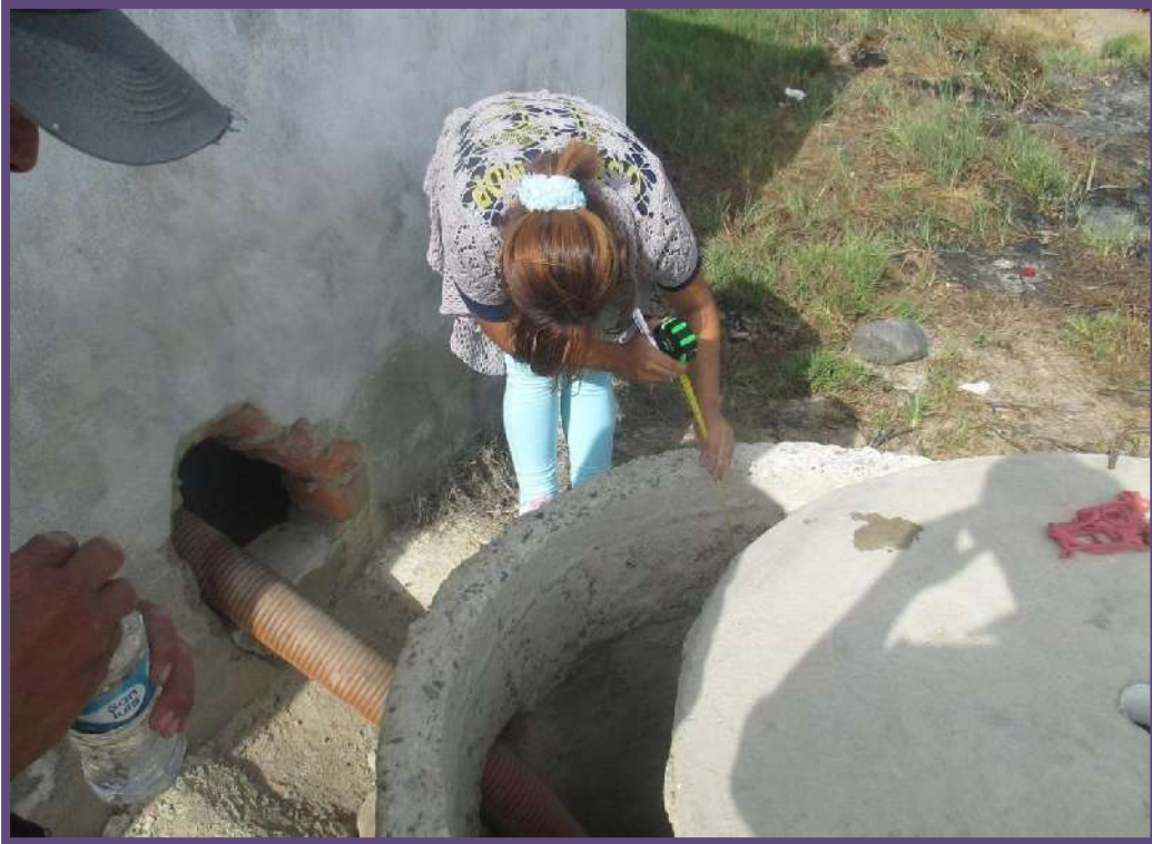
FOTO 21.A: MIDIENDO LA ALTURA DE POZO
