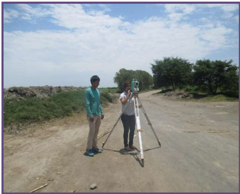
FOTO 16.A: ESTACIONANDO EL EQUIPO PARA EL LEVANTAMIENTO TOPOGRÁFICO
