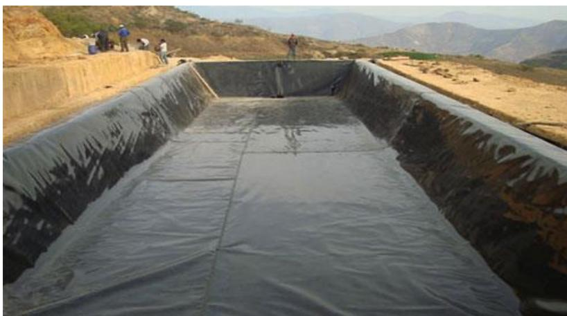
*Figura 27. Geomembrana De Alta Densidad.*
