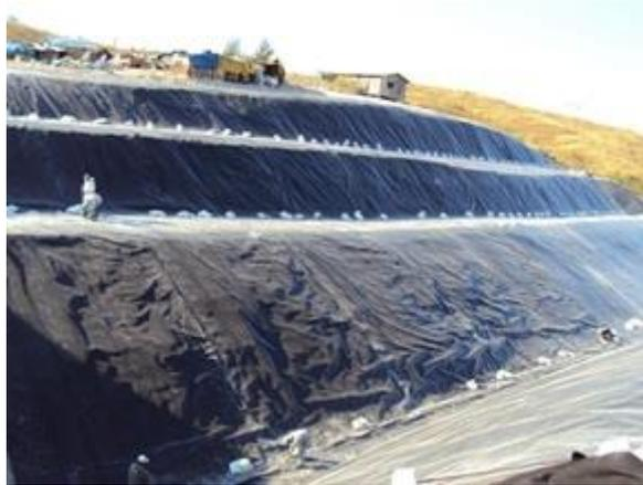
*Figura 64.* Revestimiento de una relleno sanitario con polietileno
