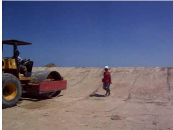
*Figura 62. Compactado de fondo de trinchera.*
