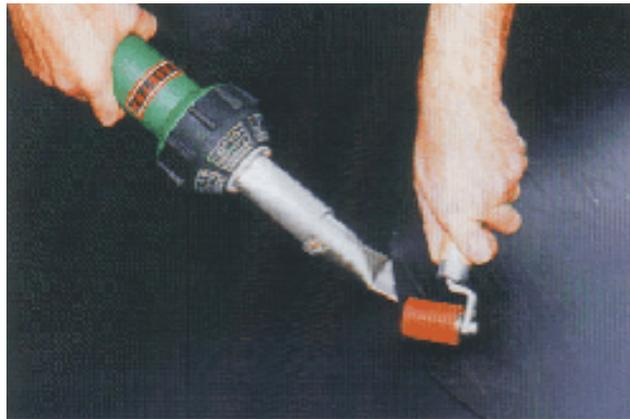
Figura 68. Fijación con el soplador de aire caliente
