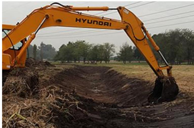
Figura 60. Excavación de las rincheras del rellenos sanitario
