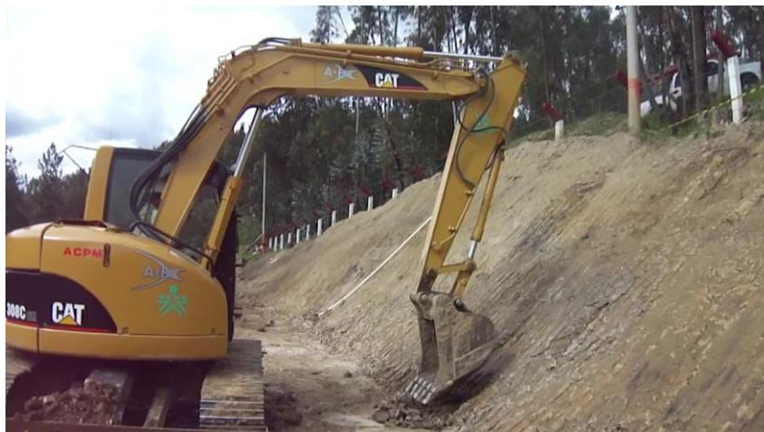
*Figura 61. Perfilado y compactado de los taludes*
