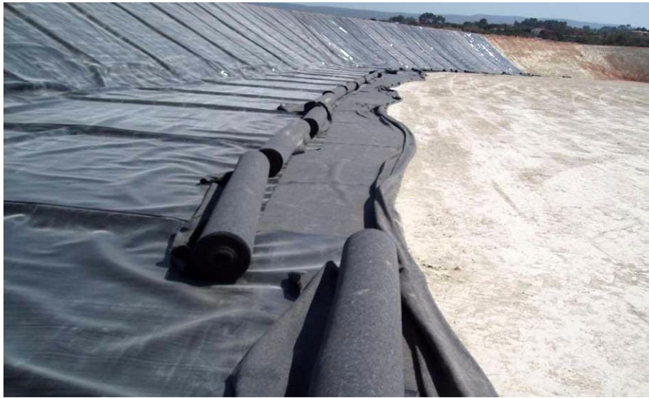
Figura 66. Extendido del geotextil en fondo de relleno
