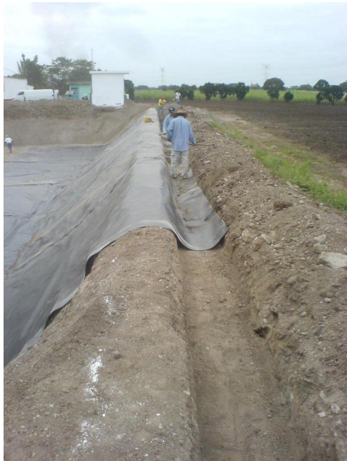
Figura 73. Trazo y nivelación del dado de anclaje
