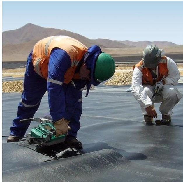
*Figura 77.* Soldadura con la utilización de la maquina
