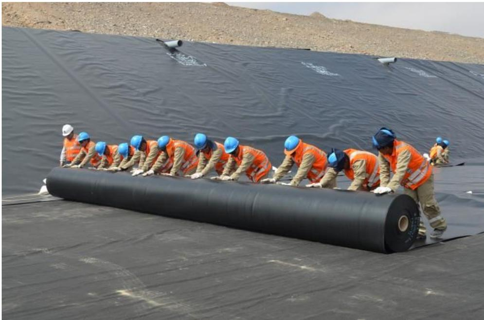
*Figura 74.* Colocación de cada panel de geomembrana.
