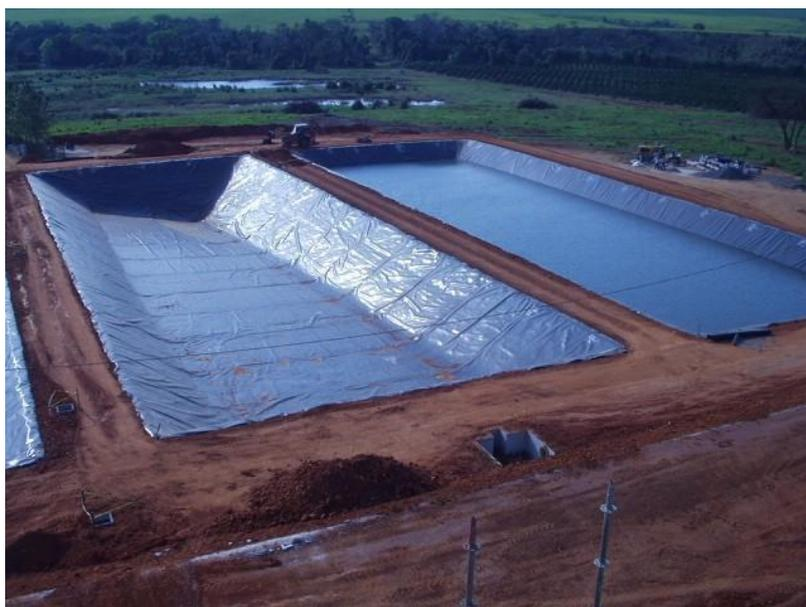
*Figura 28.* Geomembranas de Polietileno Ultra flexible.
