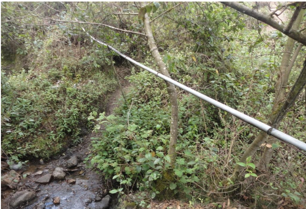
IMAGEN 19: LA IMAGEN MUESTRA LA EXPOSICIÓN DE LA TUBERÍA DE LA RED DE DISTRIBUCIÓN LA CUAL PUEDE SUFRIR DAÑOS OCACIONANDO UNA INTERRUPCIÓN EN EL ABASTECIMIENTO DE AGUA.
