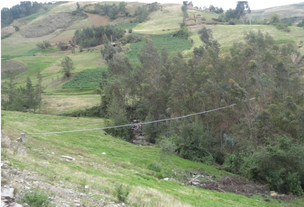
IMAGEN 28: LA IMAGEN MUESTRA UNO DE LOS PASES AÉREOS MÁ LARGOS QUE CONDUCEN EL AGUA A LAS VIVIENDAS DEL SECTOR COLPILLA.
