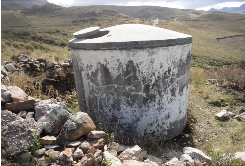
IMAGEN 34 : LA IMAGEN MUESTRA EL ESTADO OBSOLETO DEL RESERVORIO ACTUAL QUE ABASTECE AL SECTOR PEÑA BLANCA.
