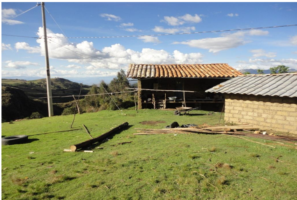
IMAGEN 33 : LA IMAGEN MUESTRA ALGUNAS VIVIENDAS QUE CUENTAN CON EL SERVICIO DE ENERGÍA ELECTRICA PARA SER CONSIDERADAS EN EL PROYECTO.
