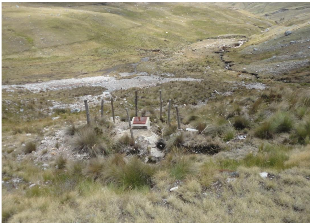
IMAGEN 02: Vistas de la captación N° 02 Las pushitas de los sectores Vaquería y Cholinorco
