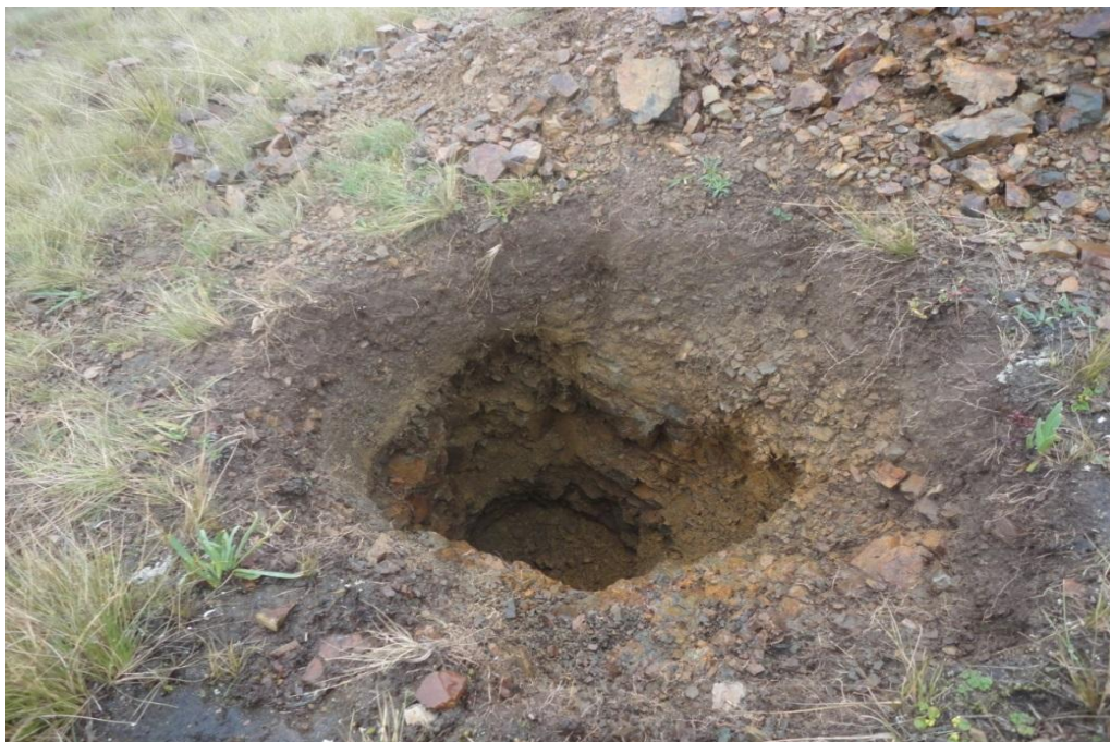
IMAGEN 29: LA IMAGEN MUESTRA LA CALICATA REALIZADA PARA DETERMINAR LA CAPACIDAD PORTANTE DEL SUELO DONDE SE CONTRUIRÁ EL NUEVO RESERVORIO DEL SECTOR PEÑA BLANCA.
