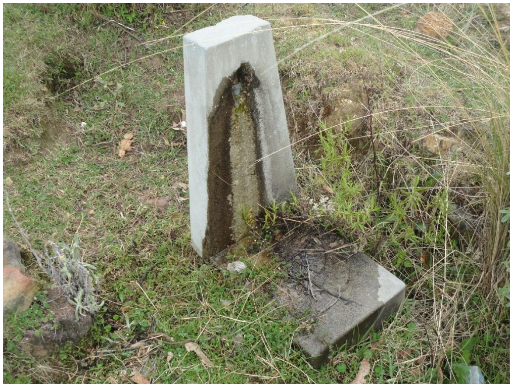
IMAGEN 11: Vista de las piletas existentes de los Vaquería y Cholinorco
