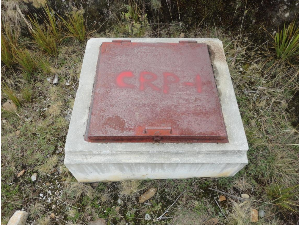
IMAGEN 08: Identificación de CRP del proyecto existente de los sectores Vaquería y Cholinorco
