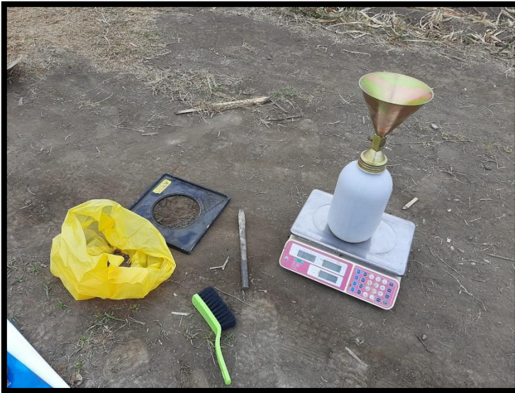
Figura 17. Ensayo de densidad de campo, método de cono de arena.
