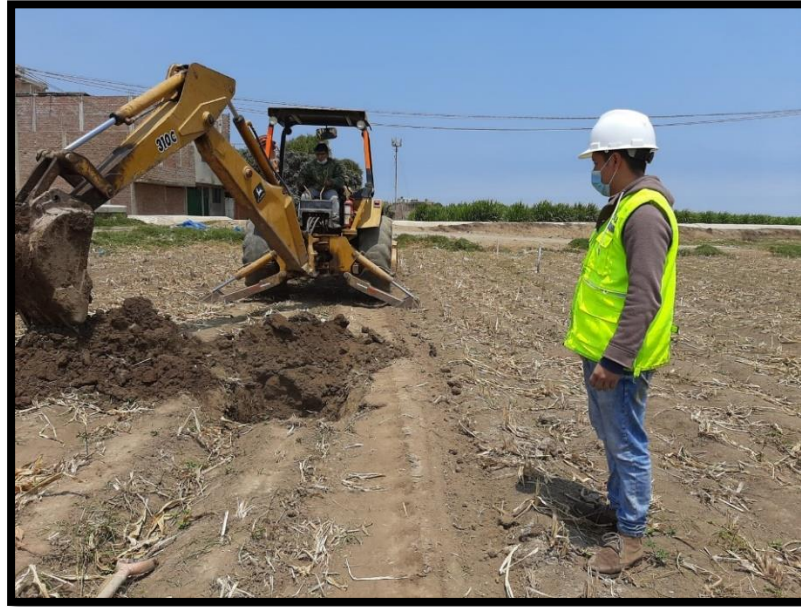
Figura 12. Empezamos con la excavación de calicatas
