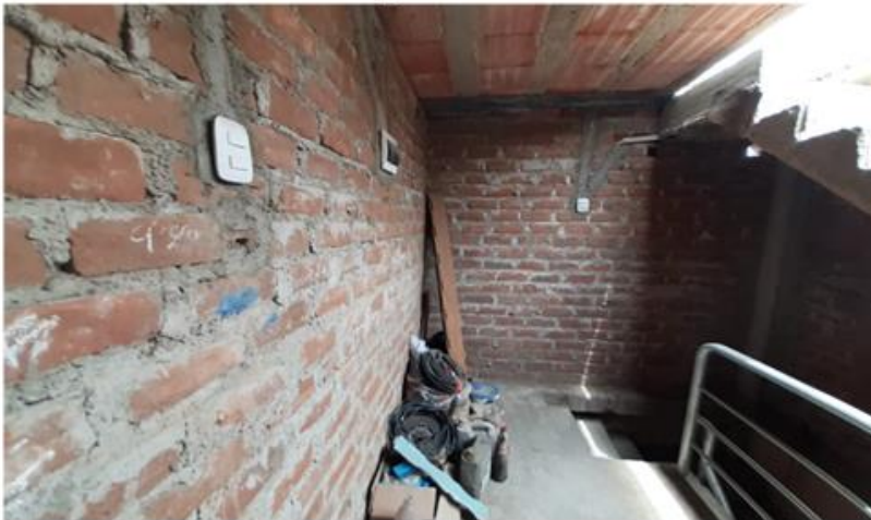
Muro con juntas mayor a 1.5 cm y armadura corroída en la escalera
