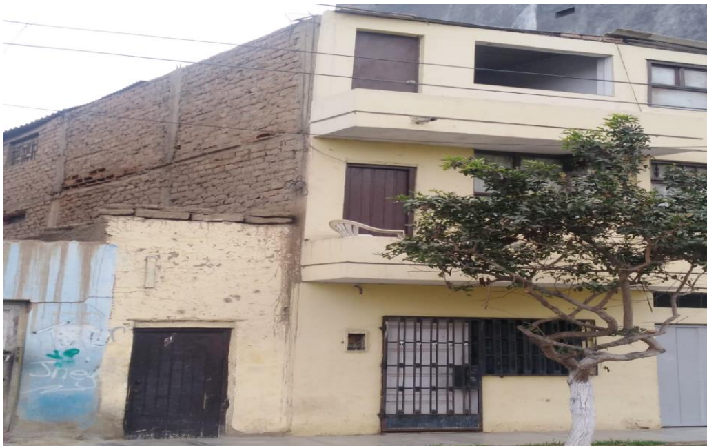
Figura 33: Ladrillos artesanales presentan dimensiones uniformes y alabeo.
