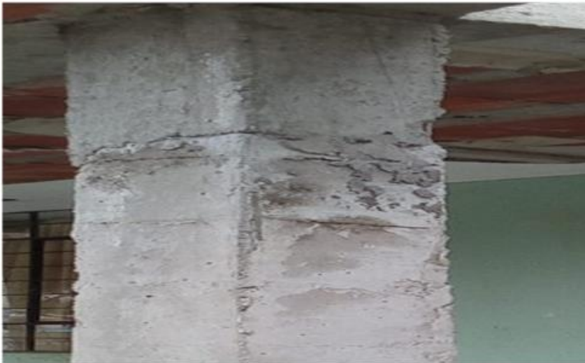
Reparación cangrejera, generación de junta fría
