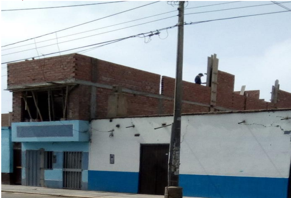
Figura 26: Ladrillo pandereta utilizado en muro portante
