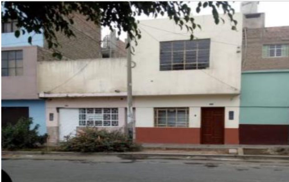
Figura 24: Ausencia de junta sísmica y techo a desnivel.
