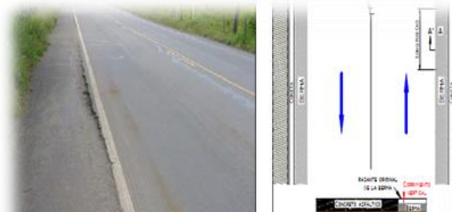
Figura 16: Separación de la Berma
